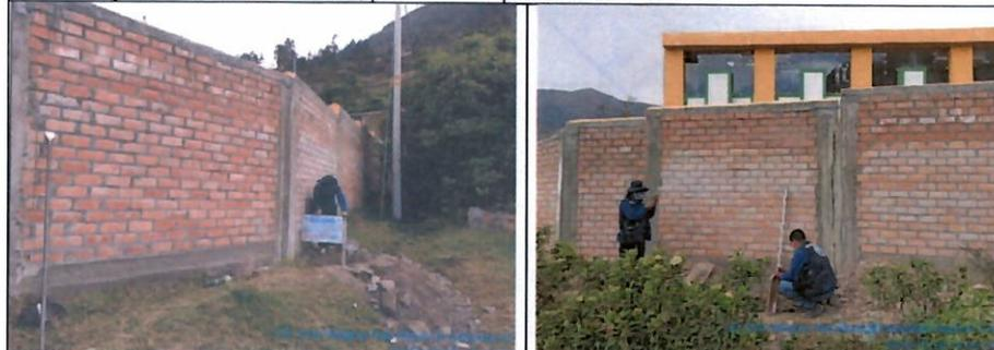
**Imagen n.º2:** En todo el Tramo E-F ejecutada con tabiques de albañilería con acabado caravista, tiene un desplazamiento medio.
