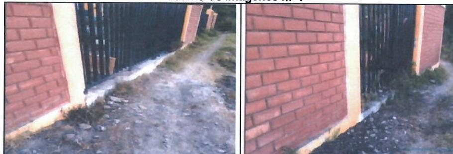
**Imagen n.º1:** En una parte del Tramo D-E donde se observa tabiques de albañilería con acabado caravista y tramos de cerco metálico, presentan desplazamiento leve.
