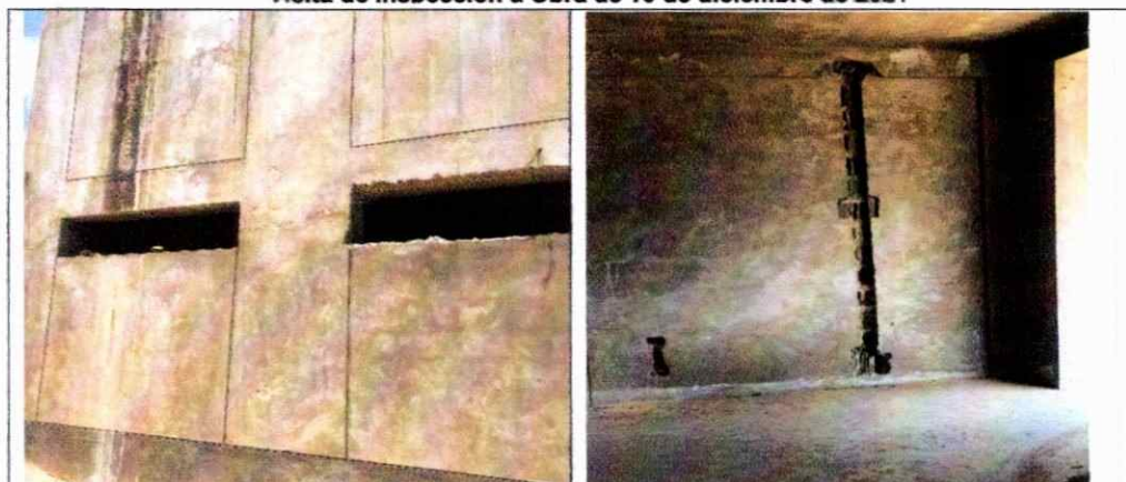
Panel Fotográfico n.º 3 Visita de Inspección a Obra de 10 de diciembre de 2021
