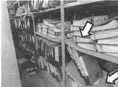
Deformación de las estanterías por exceso de carga
