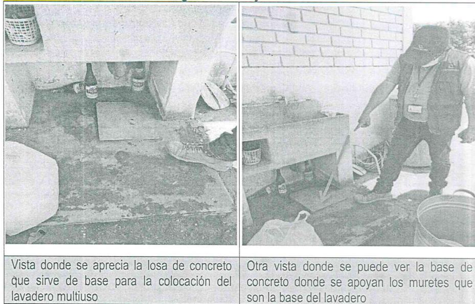
Vista donde se aprecia la losa de concreto que sirve de base para la colocación del lavadero multiuso
