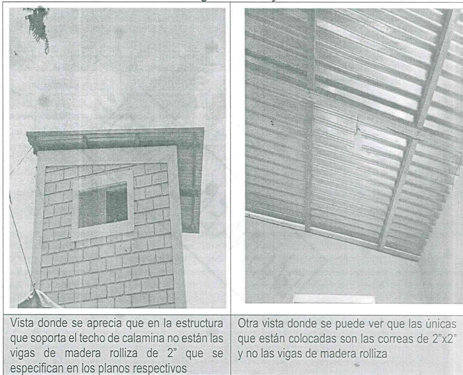
Vista donde se aprecia que en la estructura que soporta el techo de calamina no están las vigas de madera rollizo de 2" que se especifican en los planos respectivos
