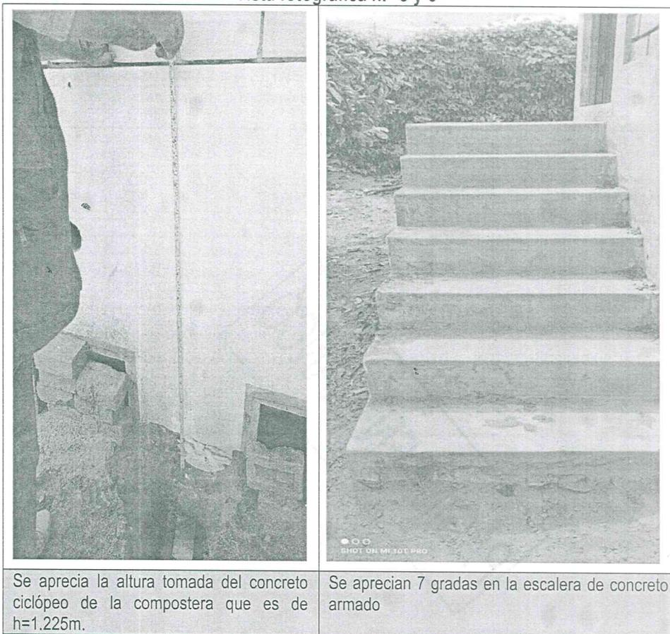
Se aprecia la altura tomada del concreto ciclópeo de la compostera que es de h=1.225m.
