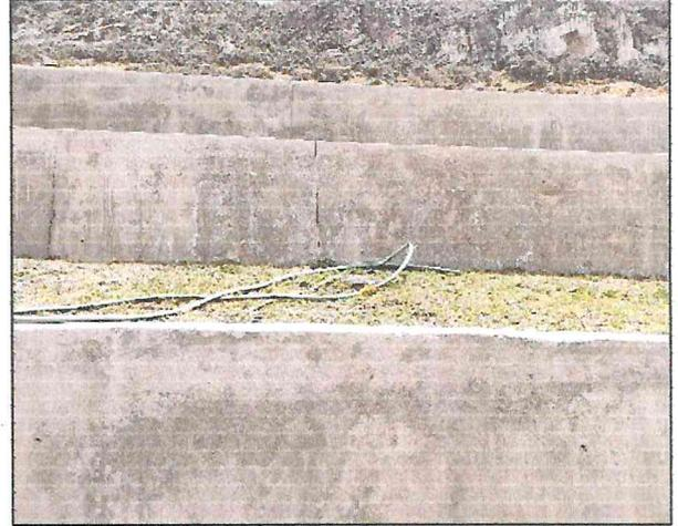
**Descripción:** La comisión de control, observó que los muros de contención, no cuentan con juntas de dilatación con asfalto, tal como lo establecía el expediente técnico aprobado.
