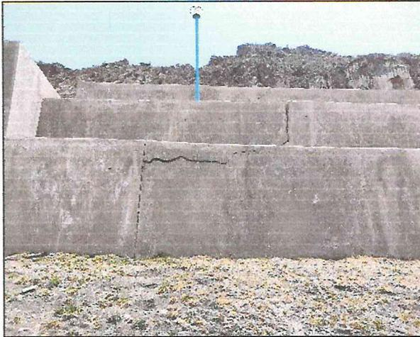
**Descripción:** Se observa que los muros de contención (de tipo andén), no cuentan con juntas de dilatación con asfalto y se encuentran fisurados.
