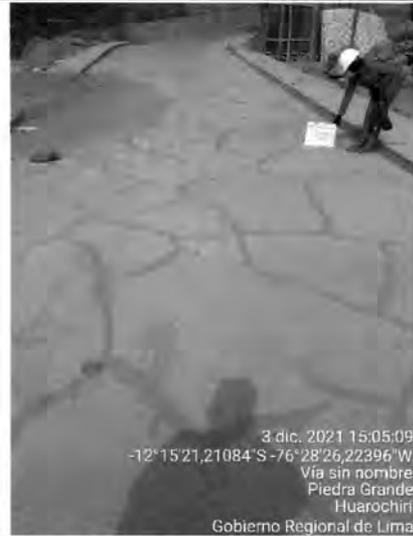
Imagen n.º 7.38: Numerosas grietas y fisuras en concreto a lo largo de la calle
