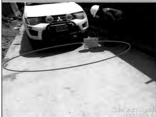
Imagen n.º 7.40: Grieta transversal a lo largo de losa de concreto
