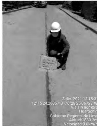
Imagen n.º 7.32: Juntas transversales y longitudinales sin tratamiento
