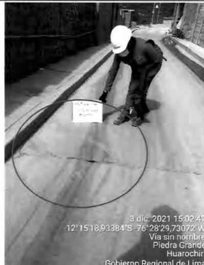
Imagen n.º 7.36: Grietas y fisuras en concreto y quiebre en arista de paño
