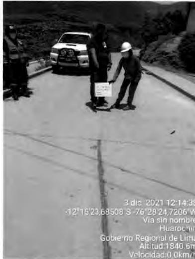
Imagen n.º 7.31: Juntas transversales y longitudinales sin tratamiento
