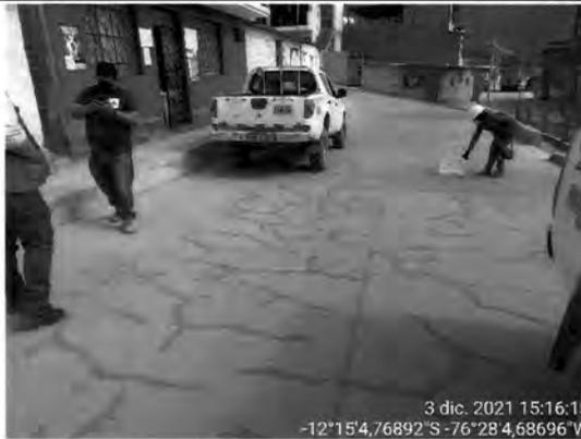
Imagen n.º 7.39: Fisuras y grietas a lo largo de losa de concreto
