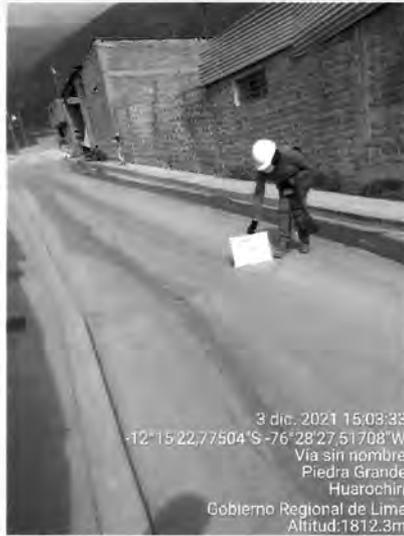
Imagen n.º 7.37: Grieta transversal a lo largo de losa de concreto
