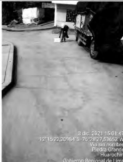
Imagen n.º 7.35: Fisuras y grietas a lo largo de losa de concreto
