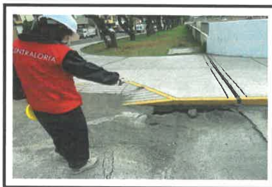
Fuente: Visita de inspección de 8 de octubre de 2020. Elaborado por: Comisión auditora.
