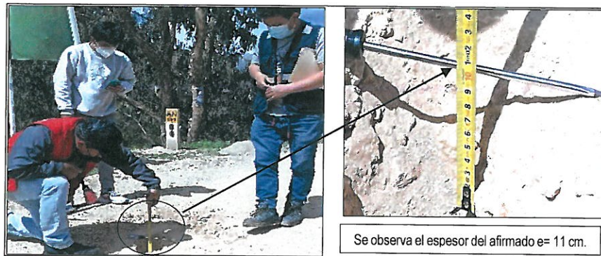
FOTOGRAFÍA N° 7 MEDICIÓN DEL ESPESOR DEL AFIRMADO (KILOMETRO 0+000)
