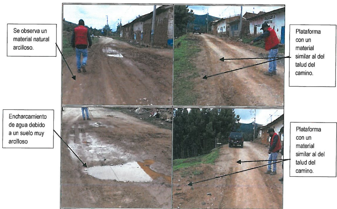
FOTOGRAFÍA N° 14 VÍA NO INTERVENIDA (LOCALIDAD DE UTUPAMPA) – TRAMO km. 5+430 al 5+920
