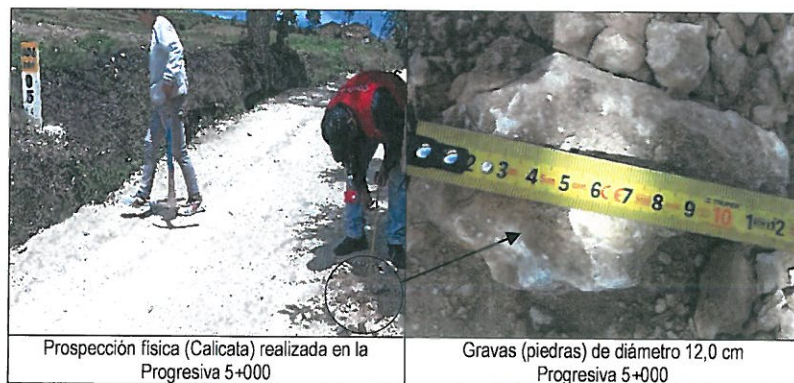
FOTOGRAFÍA N° 3 MEDICIÓN DE LAS PARTÍCULAS DE AFIRMADO
