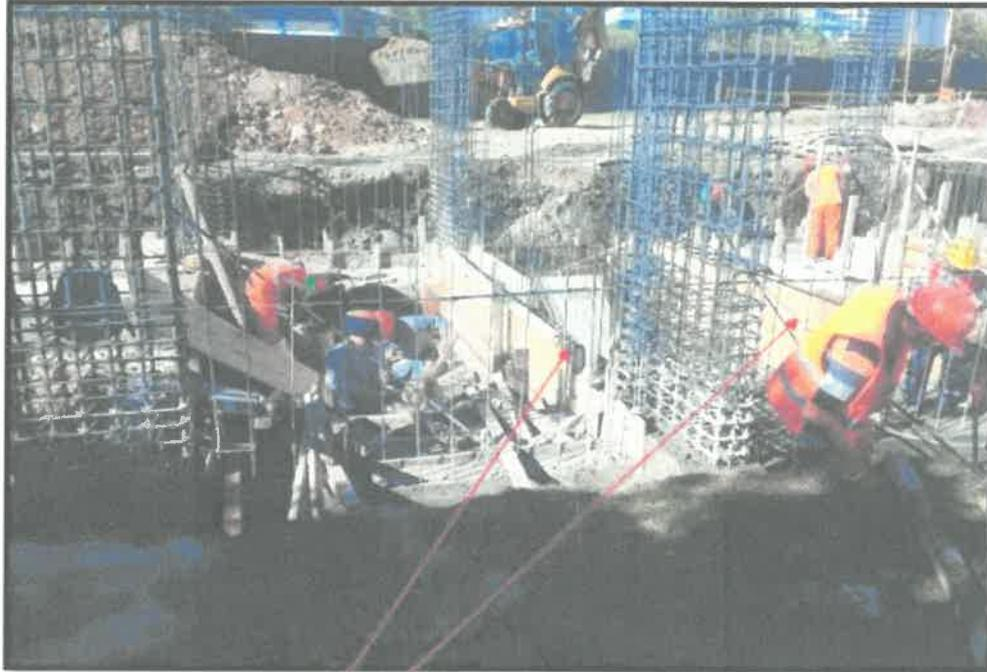
Obsérvese, que el contratista a ejecutado el encofrado de vigas de cimentación en las áreas del gráfico precedente aparecen como achuradas, lo cual comprueba que la referida área no ha sido vacada con concreto.
