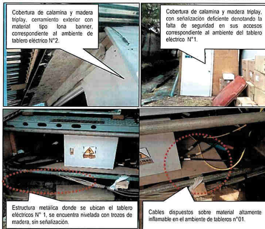
IMAGEN N° 4 ESTADO DE LOS AMBIENTES DONDE SE UBICAN LOS TABLEROS ELÉCTRICOS
