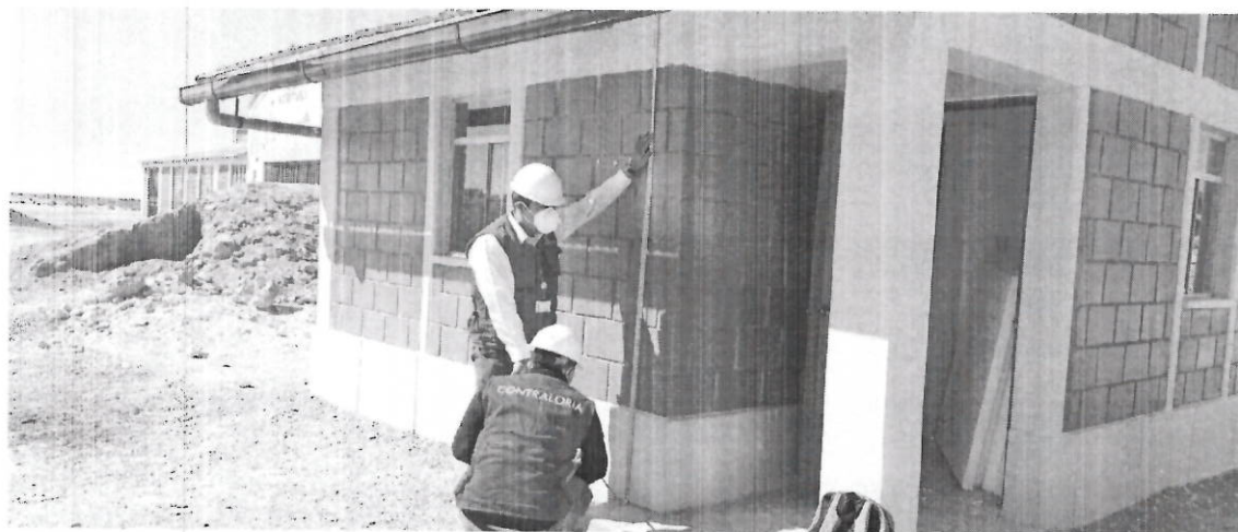
Vista fotográfica n.º 5 Verificación de especificaciones para exteriores de la vivienda Sumaq Wasi
