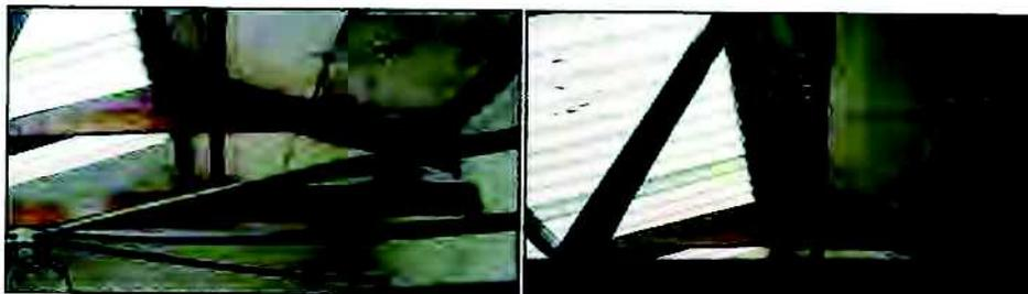
Fotografías n.º 1 y 2: Se aprecia el colocado de planchas de tecnopor en la cobertura de la parte interior del módulo, más no se evidencia el colocado del tendido de la lana de vidrio que debería estar fijada sobre las planchas de los fibrocementos.
