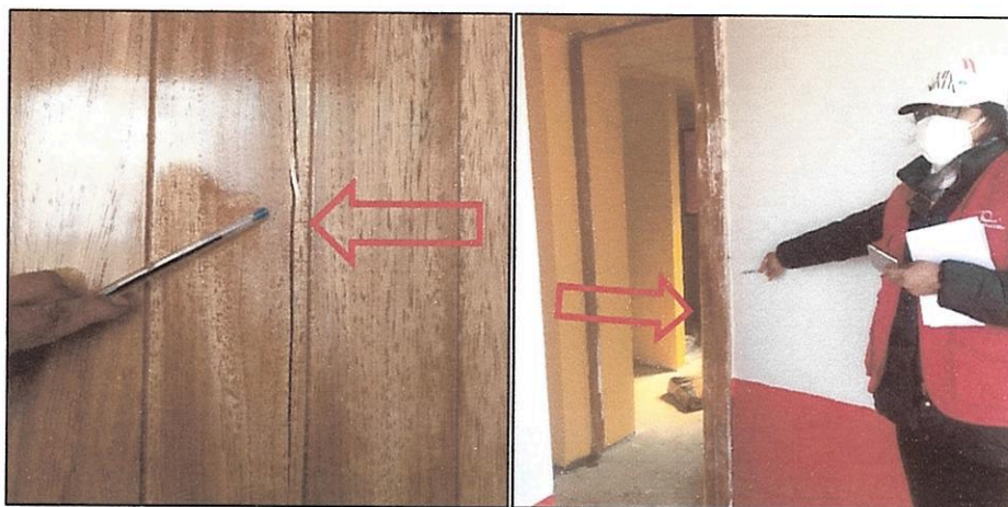
Fotografías n.ºs 11 y 12: Imágenes donde se advierte rajaduras en la fibra de la madera y marcos con deformaciones Fuente: Verificación física a la ejecución del Convenio del 1 al 7 de octubre del 2020.
