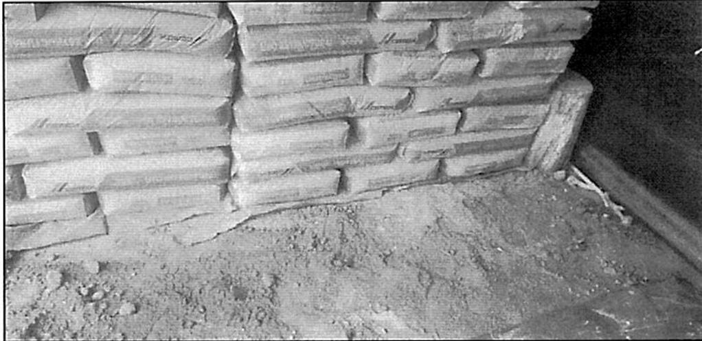
**Descripción:** Bolsas de cemento colocadas directamente sobre el terreno natural cubierto con plástico.
