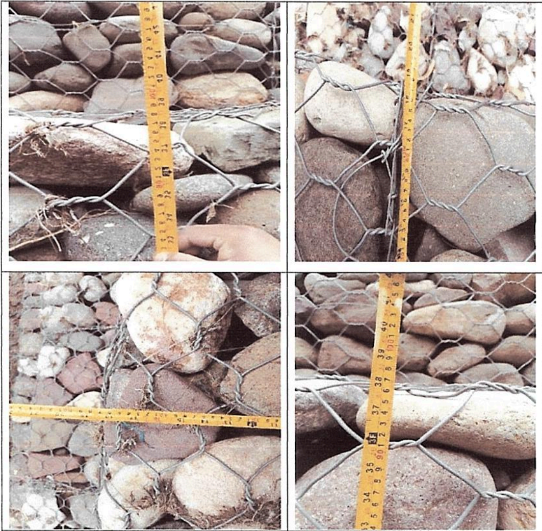
Las Fotografías n° 06, n° 07, n° 08, n° 09, n° 10 y n° 11, muestran las alturas y anchos de la caja gavión tipo A y B, la cual cabe precisar no se contrasta con los plano del Expediente Técnico.
