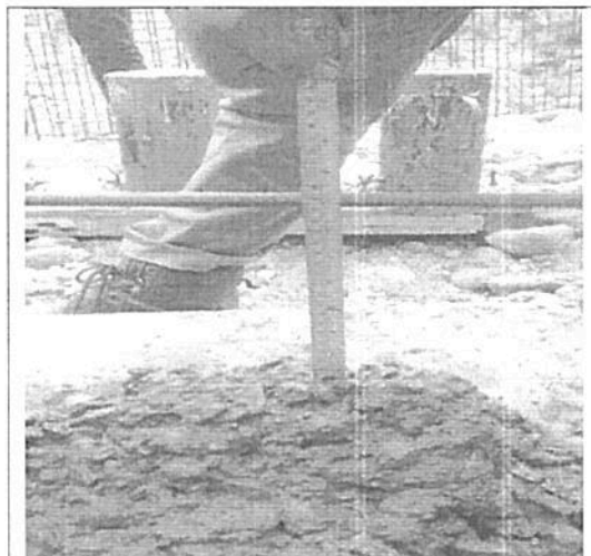
Imagen n.º 9: Medición del asentamiento de concreto verificándose medidas de 0.16 m.
