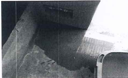
Foto n.º 17: Vista de retención de agua en piso pulido, por inadecuada ejecución de pendiente hacia sumidero.
