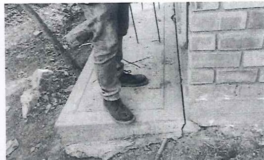
Foto n.º 20: Vista de desprendimiento de vereda por falta de compactación e inadecuada ejecución
