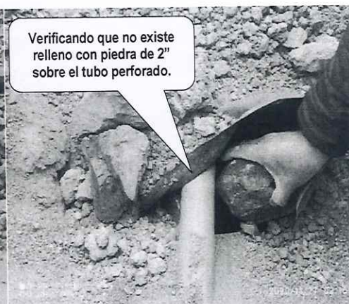
Foto n.° 40: Vista de relleno de piedra al costado de tubería
