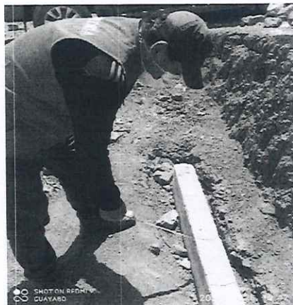
Foto n.º 9: Vista de fisuras en toda la longitud de sobrecimiento
