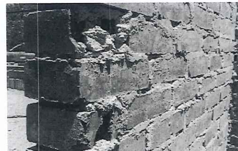
Foto n.º 15: Vista de pésima colocación de juntas verticales y horizontales de mortero en asentado de ladrillos.
