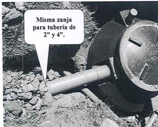
Foto n.° 25: Vista de tubería de 2" y 4" conducidas en una misma zanja.
