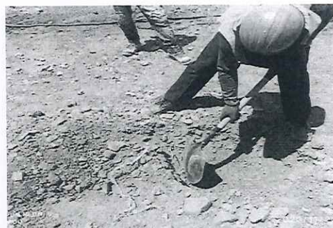
Foto n.º 46: Vista de material rocoso empleado como relleno en zanjas de infiltración.
