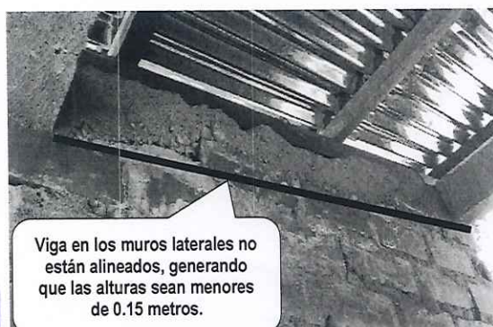
Foto n.º 3: Vista de viga lateral en caseta, que no presenta sección continua
