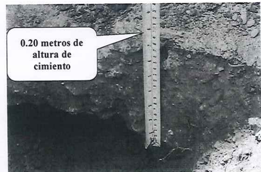
Foto n.° 2: Vista de cimiento con una altura de 0.20 m
