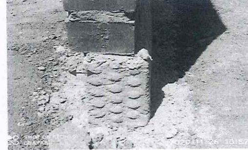
Foto n.º 14: Vista de muro desalineado con respecto a sobrecimiento
