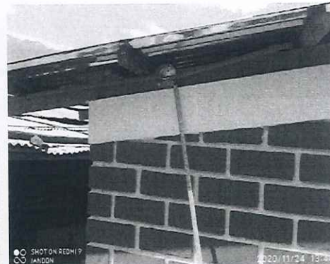
Foto n.° 24: Vista de caja octogonal sin la tapa ciega
