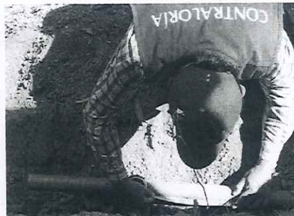
Foto n.º 42: Vista de tubería perforada, 2 perforaciones paralelas cada 15 cm.
