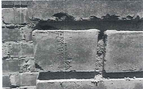
Foto n.º 11: Vista de muro con ladrillo con aristas desgastadas.
