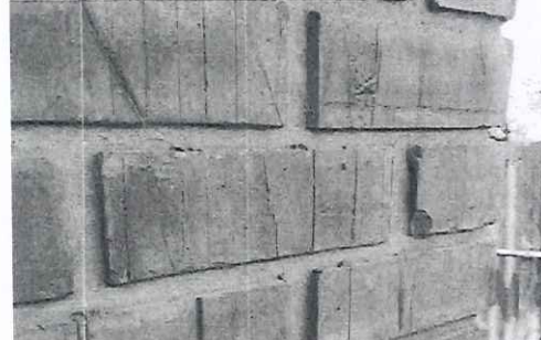
Foto n.º 13: Vista de ladrillo con cortes utilizado en muro.
