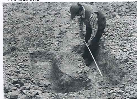
Foto n.º 38: Zanja de infiltración de dimensiones 1.40*0.4*0.4
