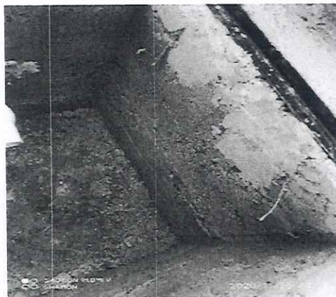
Foto n.º 31: Vista del interior de caja de registro de lodos, con muros con presencia de cangrejeras y mal acabados.
