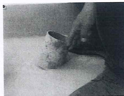
Foto n.º 30 Vista de salida de 4" para inodoro, inclinada
