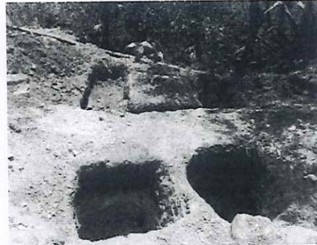
Foto n.º 36: Zanja de infiltración de dimensiones 1.70*0.60*0.45
