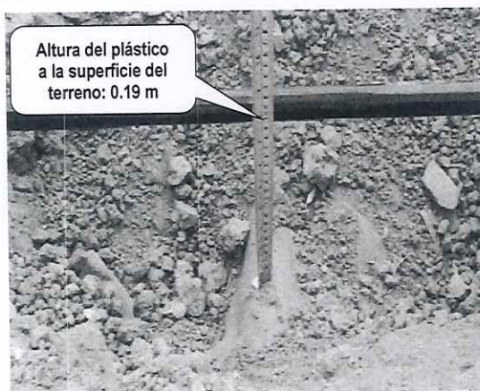
Foto n.° 39: Altura de lomo de tubería a nivel de terreno natural 0.19m
