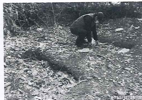
Foto n.° 34: Zanja de infiltración de dimensiones 1.50*0.60
