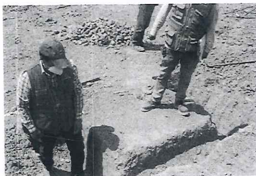
Foto n.° 33: Zanja de infiltración de dimensiones 1.50*0.50*0.55
