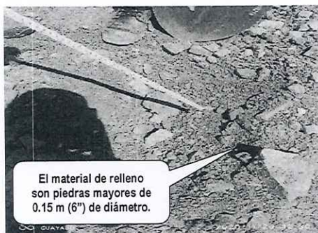
Foto n.º 45: Vista de material rocoso sin zarandear empleado como relleno en zanjas de infiltración.
