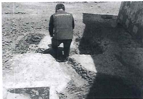
Foto n.º 37: Zanja de infiltración de dimensiones 1.50*0.50*0.55
