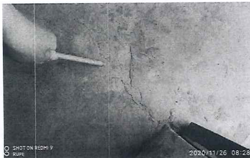
Foto n.º 19: Vista de fisura con inicio en esquina de vano de puerta.
