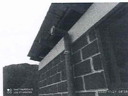
Foto n.º 28: Vista de montante de ventilación típica
