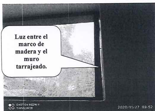
Foto n.º 21: Vista de luz existente entre marco de ventana y muro de albañilería.
