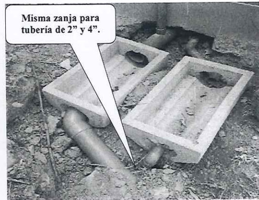
Foto n.° 26: Vista de tuberías que salen de caja de registro conducidas a través de una misma zanja
