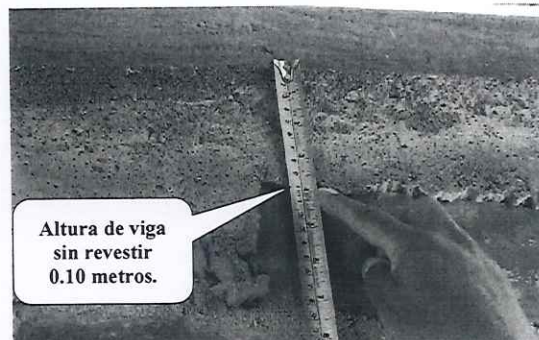
Foto n.º 4: Vista de viga con altura de 0.10m en eje lateral.
