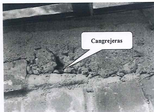
Foto n.º 6: Vista de cangrejas en viga, por deficiente vaciado.
