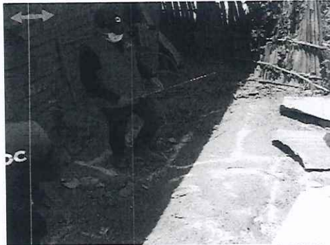
Foto n.º 35: Zanja de infiltración de dimensiones 1.50*0.60
