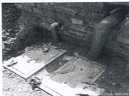
Foto n.º 29 Vista de tubería de 2" y 4" expuestas a la intemperie.
