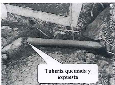
Foto n.º 27 Vista de tubería quemada por exposición al fuego.
