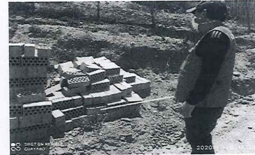
Foto n.º 16: Vista de mal apilamiento de ladrillos, provocando fallas en los mismos.
