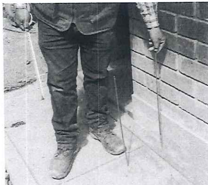
Foto n.° 7: Vista del acero para base de lavadero, superpuesto sobre perforación en vereda.
