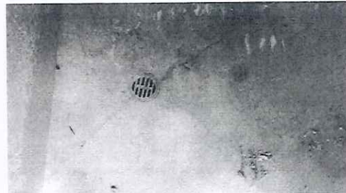
Foto n.º 18: Vista de fisura en piso de cemento pulido
