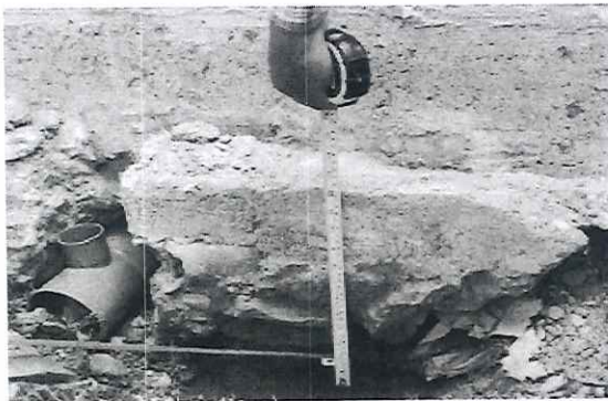
Foto n.° 1: Vista de altura de cimiento que no es continua en su profundidad
