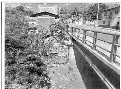
Se advierte la no construcción de muro de contención n.º 1, proyectado en Jr. Cajamarca (00+180)
