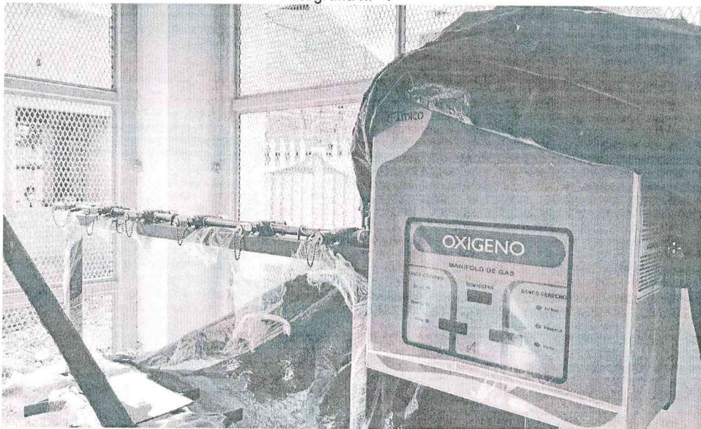
Manifold de Oxígeno Dúplex de 24 cilindros de 10m3 c/u (12 por cada lado)
