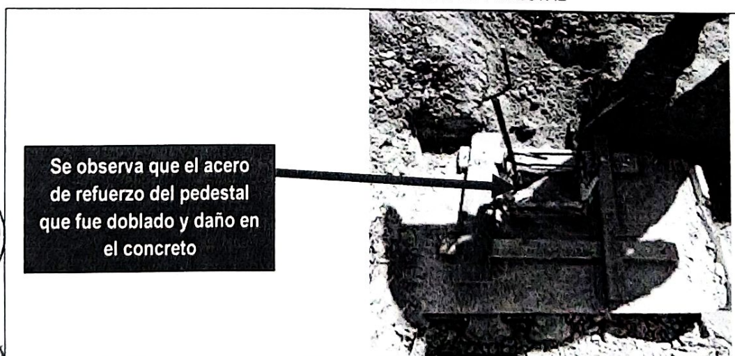
Imagen N° 3 ACERO Y CONCRETO DEFICIENTES EN PEDESTAL
