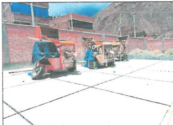
Fotografía n.º 45: Se muestra maquinaria mezcladora de concreto, la cual se encuentra en la intemperie
