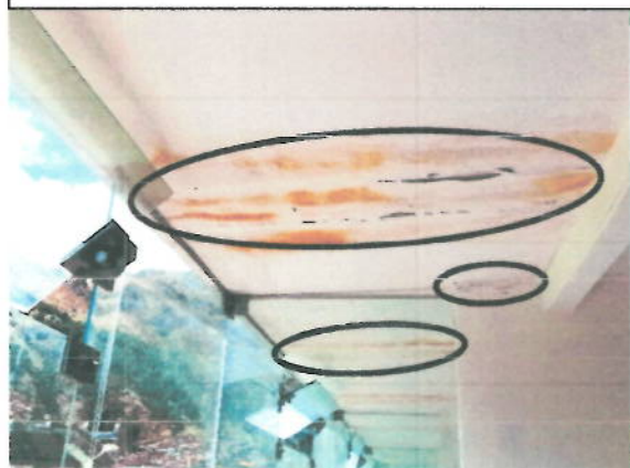
Fotografía n.º13: Se evidenció fisuras en los techos drywall en las cabinas de radio y tv del estadio.
