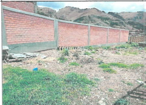
Fotografía n.º 48: Se observa en la imagen escalera de madera tendido en el suelo a la intemperie.
