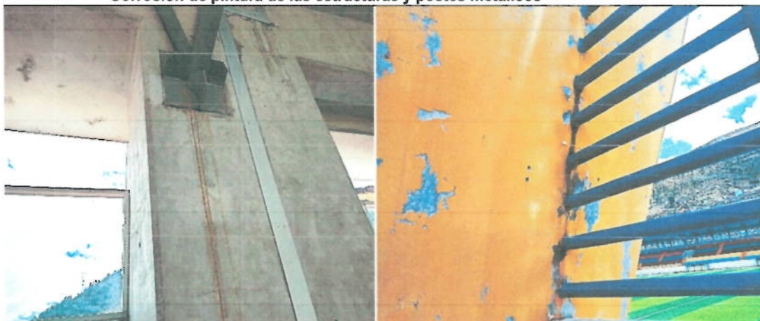
Fotografía n.º 30: Corrosión de pintura en postes metálicos del cerco que se une con el muro de concreto de las cabinas de radio y TV
