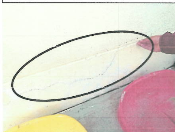
Fotografía n.º17 y 18: Se evidenció fisuras horizontales en los muros inferiores de la tribuna sur principal, que se encuentran cerca y colinda con las bancas de suplentes, cunetas y pista atlética.
