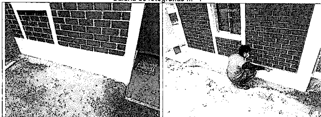
Fotografía n.º 1 y 2: De la verificación a los módulos habitacionales, se advierte que el zócalos de cemento sobre muro exterior, no cuenta con la ejecución de bruñas verticales de 1cm de espesor a cada 0.75m de separación
