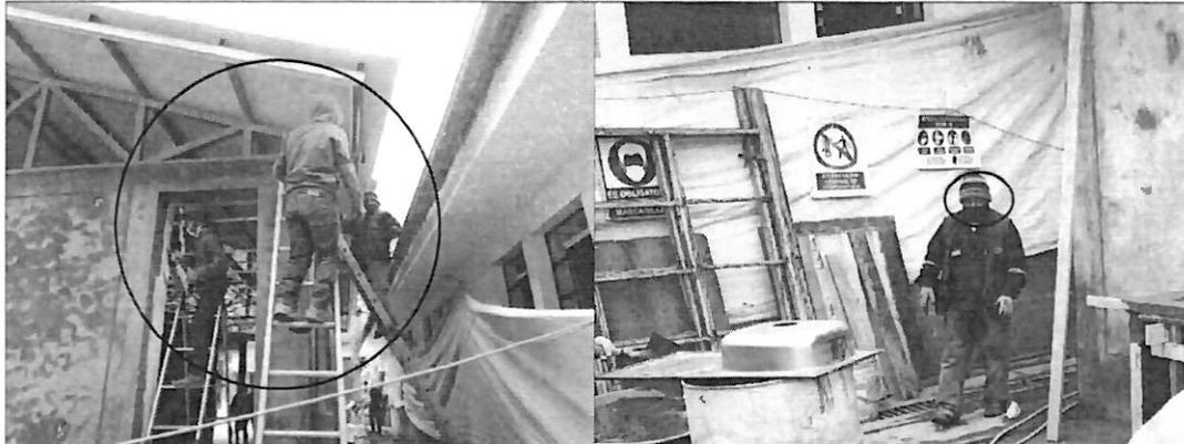
Imagen n.º 22 y 23: Se advierte que los trabajadores no cuentan con implementos de seguridad, faltando en algunos protectores de manos (guantes), protectores de pies (botas puntas de acero), cascos de seguridad, protectores visuales y respiratorios.
