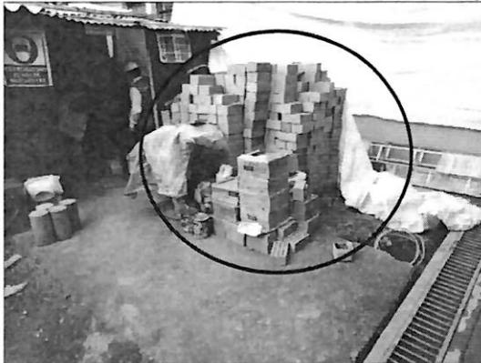
Imagen n.º 4: Existencia de ladrillos, cerámicos y botes de pintura en el piso al aire libre sin cobertura, ubicadas en la parte posterior de la ejecución de la construcción.
