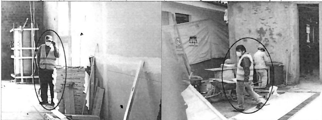
Imagen n.º 24 y 25 : Se puede verificar que los trabajadores que vienen laborando no cuentan implementos de seguridad, faltando en algunos protectores de manos (guantes), protectores de pies (botas puntas de acero), cascos de seguridad, protectores visuales y respiratorios.
