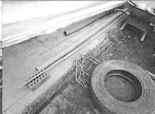
Imagen n.º 5: Existencia de tubería de agua y desagüe en el piso al aire libre sin cobertura, ubicada en la parte posterior de la ejecución de la construcción.
