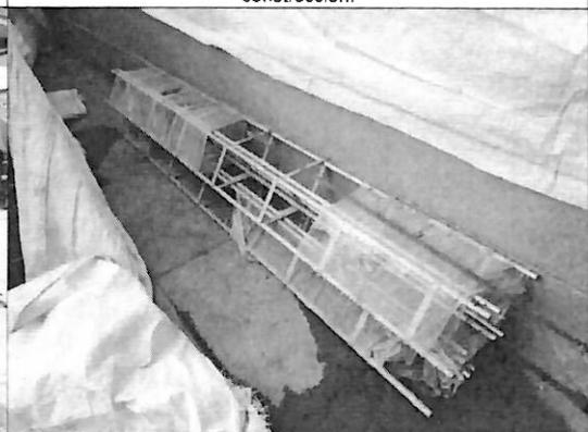
Imagen n.º 9: Existencia de soportes estructurales de la del pararrayos, sobre el piso a la intemperie, ubicados en la parte posterior de la ejecución de la construcción.
