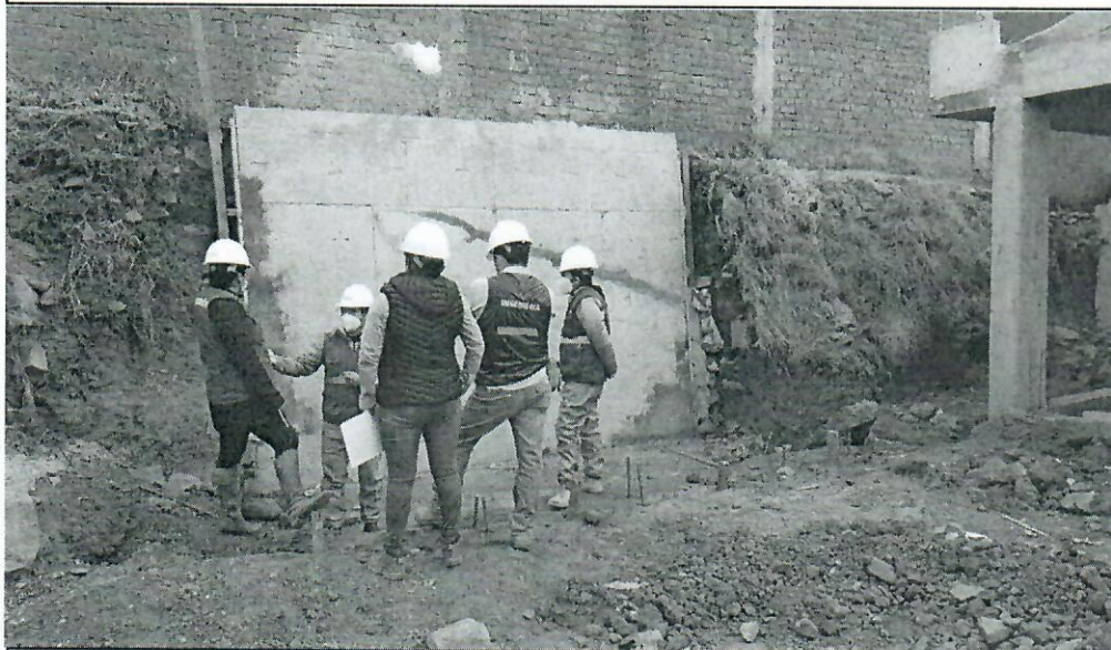
Registro fotográfico N.º 02 del muro de contención de concreto armado valorizado en la valorización N.º 06 como concreto ciclópeo.
