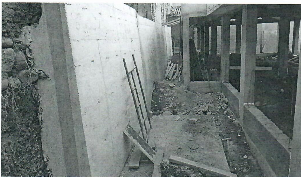
Registro fotográfico N.º 01 del muro de contención de concreto armado valorizado en la valorización N.º 05 y valorización N.º 06 como concreto ciclópeo.
