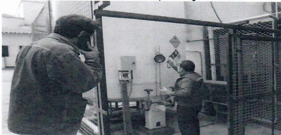
**Leyenda:** En la imagen se observa que del tanque de oxígeno instalado en el Hospital Belén salen diversas tuberías las cuales gran parte de ellas se encuentran despintadas.
