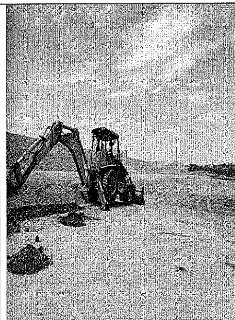
Imagen 15.- Retroexcavadora realizando los trabajos de excavación.
