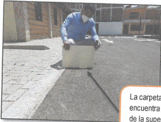
Registro fotográfico n.º 7 Pasaje Santa Toribio
