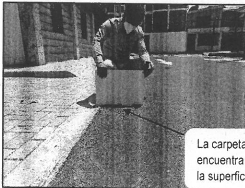
Fotografía n.º 3 Pasaje Santa Toribio
