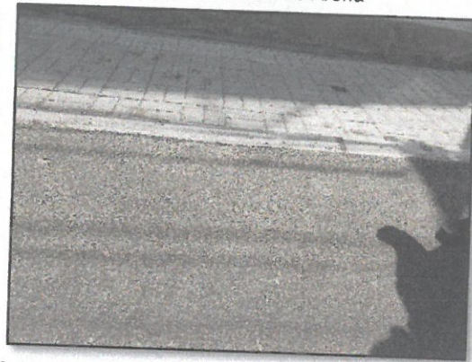
Registro fotográfico n.º 2 Calle San Juan de Arona
