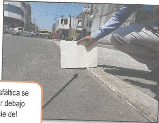
Registro fotográfico n.º 8 Calle Los Pinos
