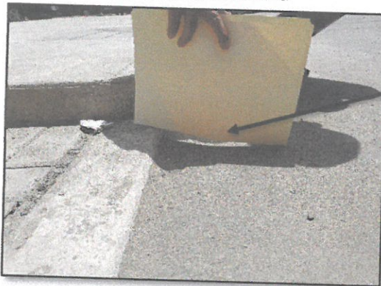
Registro fotográfico n.º 9 Calle San Juan de Arona
