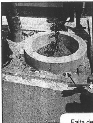
Fotografía n.º 6 Pasaje Santa Toribio
