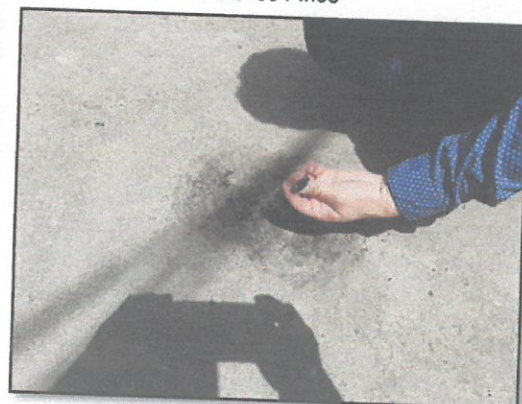
Registro fotográfico n.º 6 Calle los Pinos
