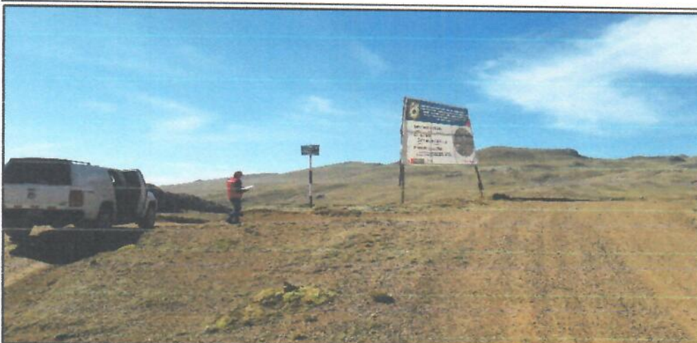
Desviación de Pallcapampa a Pucacucho y desvío Huamanrazu, sin presencia de mejoramiento de afirmado ni movilización de maquinarias, ni personal laborando.
