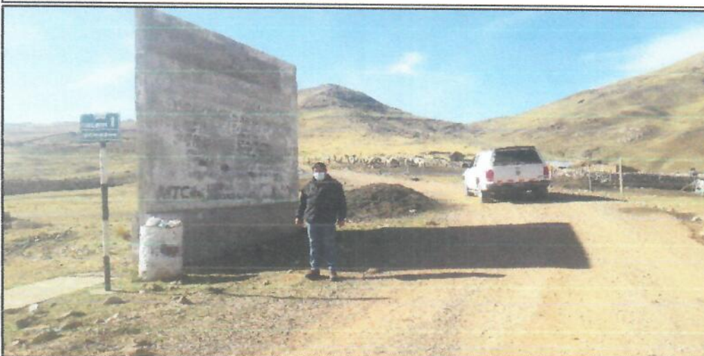
Punto final del Proyecto Km 37+000 Titicaca ruta a Pallcapampa, sin presencia de mejoramiento de afirmado ni movilización de maquinarias, ni personal laborando.
