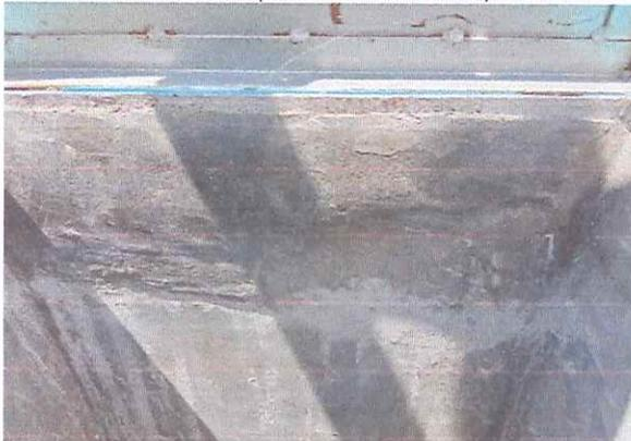
Foto n.º 07: Vista de rebabas en tarrajeo interior de cámara rompe presión.
