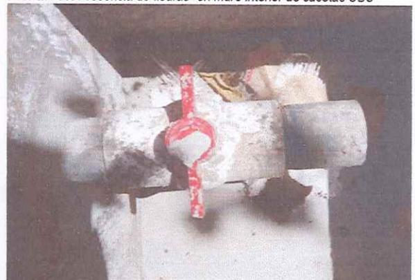
Foto n.º 08: Vista interior de caja de lodos, con llave de paso cubierta de concreto.
