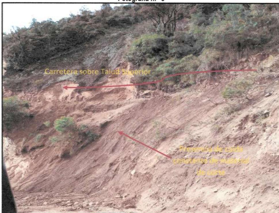
Vista de material de corte que se vienen desprendiendo del talud superior a hacia la calzada de la vía en el tramo Yumal – San Jun del Rejo.
