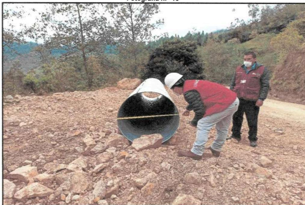
Vista de la tubería TMC ensamblada para la posterior instalación en alcantarilla, en el tramo San Juan de Rejo – San Miguel de Poro Poro.
