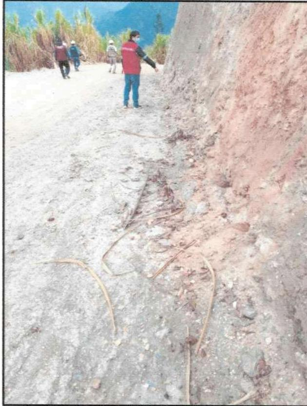
Se muestra la falta de conformación de cunetas, luego de culminados los trabajos de corte en taludes y desbroce y limpieza de la vía.
