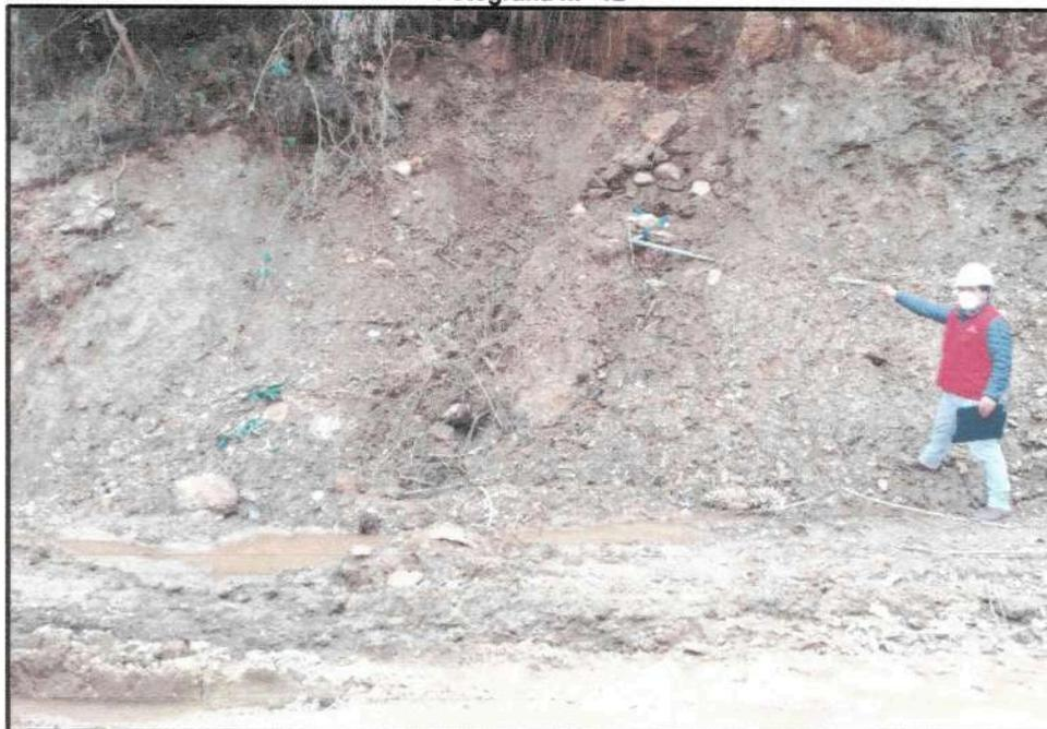
Vista de la inexistencia de cunetas y falta de continuidad de la misma, presentando acumulación de agua, pudiendo deteriorar la sub rasante conformada.
