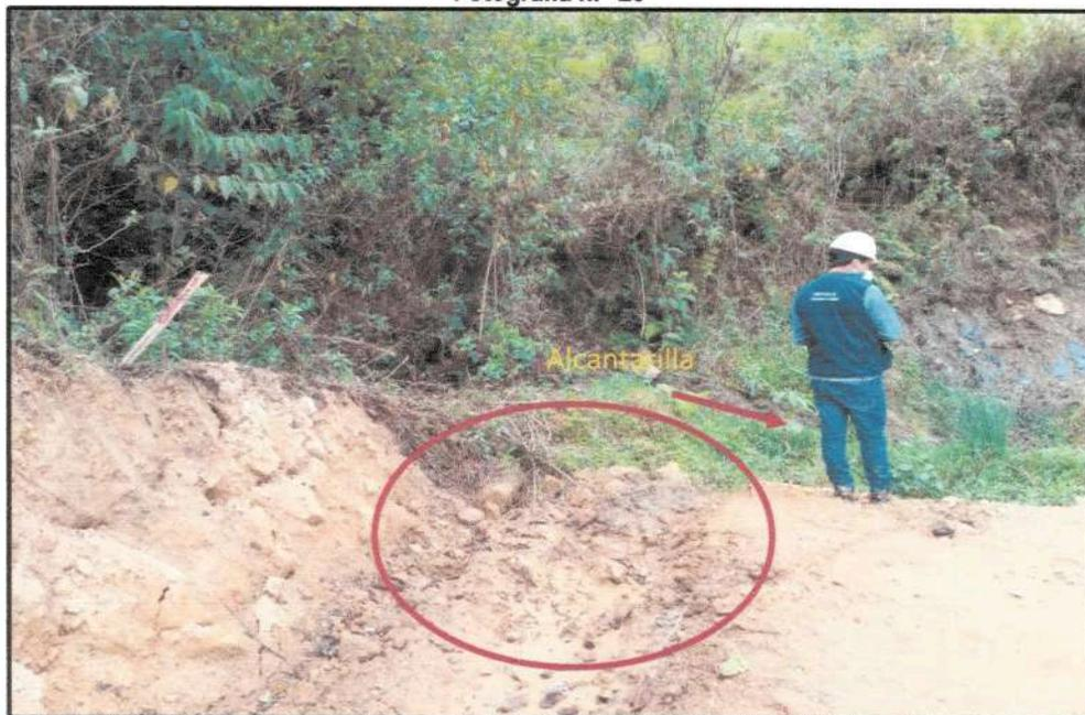
Se muestra la falta de continuidad de las cunetas hacia las alcantarillas, no permitiendo un adecuado drenaje de las aguas de lluvia.
