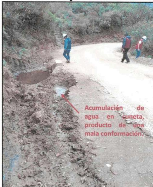
Vista de otra de las alcantarillas con drenaje inadecuado, asimismo se aprecia mala conformación de cunetas conllevando a acumular agua de lluvia en esta afectando la calzada adyacente de la vía
