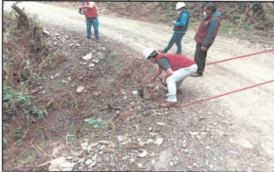
Vista de alcantarilla existente completamente obstruida producto de la eliminación de material de corte, situación que no estaría permitiendo drenar adecuadamente las aguas de lluvia.
