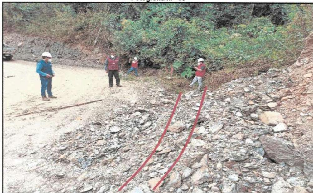
Se muestra la falta de corte en roca fija, no contando con la conformación de cuneta, así como falta de eliminación de material de corte en roca fija.
