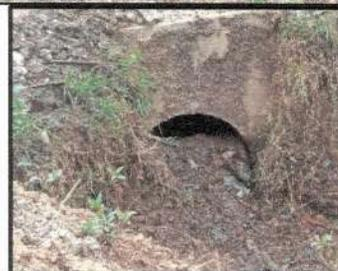
Vista de alcantarilla TMC que se encuentra tapada con material eliminado proveniente de los trabajos de corte realizados.
