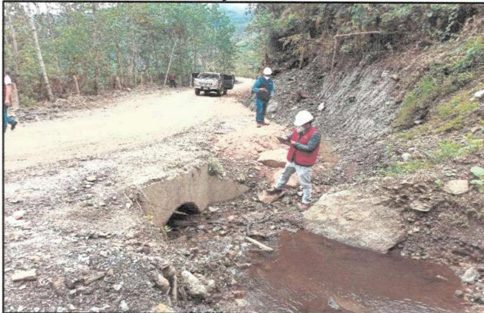
Vista de alcantarilla existente, la cual presenta acumulación de material en el ingreso, presentando acumulación de agua por la falta de un drenaje adecuado.
