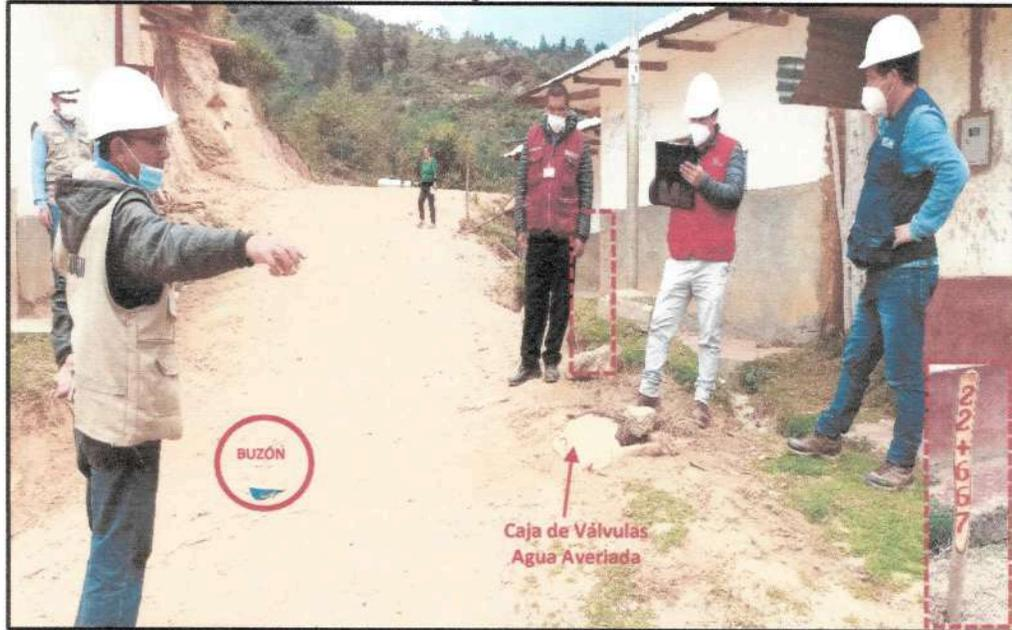
Vista de caja de agua potable averiada y buzón de alcantarillado completamente tapado.
