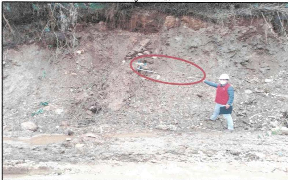
Vista de tubería de agua potable expuesta, producto de los trabajos de corte realizados en taludes, a la altura del caserío San Juan del Rejo.
