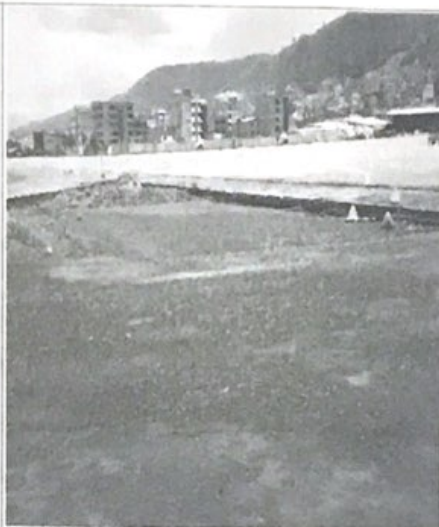
Foto 2: Vista de la obra expediente adicional
