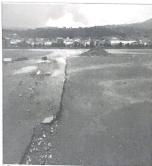
Foto 1: Vista de la obra calle Bravo
