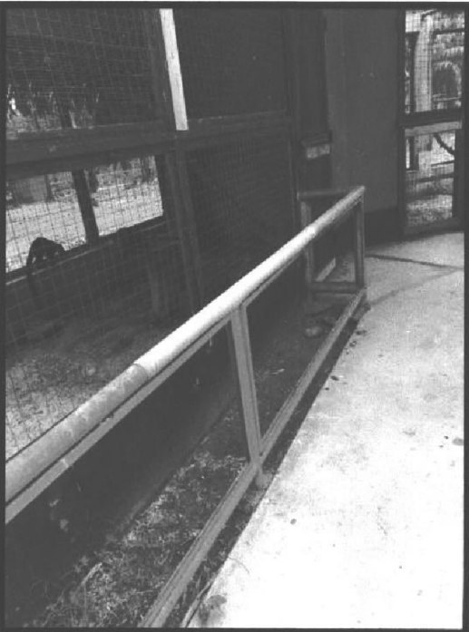
Imagen n.º 5 y 6 Barandas oxidadas y deterioradas
