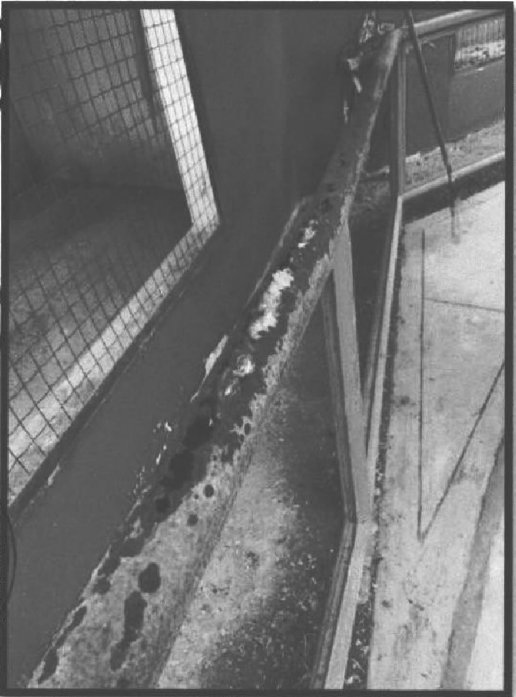
Imagen n.º 5 y 6 Barandas oxidadas y deterioradas
