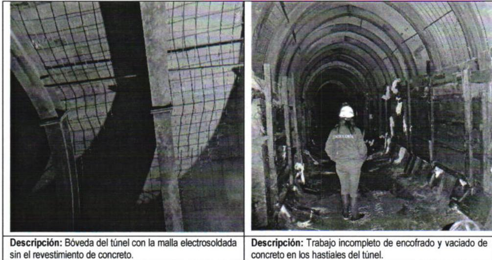
**Descripción:** Bóveda del túnel con la malla electrosoldada sin el revestimiento de concreto.
