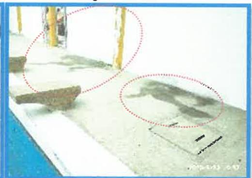
En las áreas encerradas en circunferencias se advierte charcos de agua y humedecimiento de las vigas, columnas y muros por problemas de filtración de las aguas pluviales que ingresan por el techo de la piscina.
