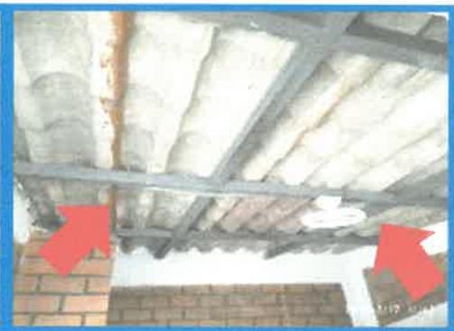
En la imagen se observa el techo del área de la caseta de control, el cual no cuenta con cielo raso, por lo tanto, se consideró una partida con un metrado inexistente.
