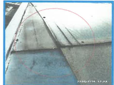
En las áreas encerradas en circunferencias se advierte que las planchas de policarbonato no tienen perfiles de unión, no están selladas con silicona, se encuentran onduladas y presentan hoyuelos, por las cuales vienen filtrando las aguas pluviales; debido a que no se especificó la realización de estos trabajos para subsanar estas deficiencias.
