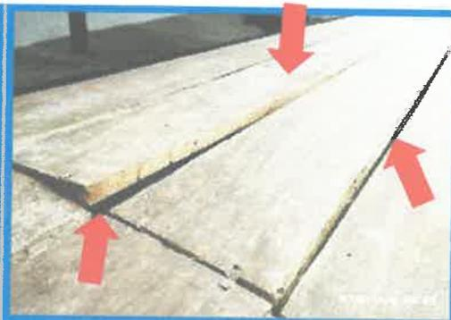
En las áreas indicadas, se muestra que la madera de las bancas del área de la piscina, presenta grietas, torceduras, se tiene espacio entre las uniones de las maderas y la fijación con tornillo entre la madera y el metal no es fijo ya que se tiene maderas levantadas; asimismo, que el barnizado o pintado no es uniforme; por lo tanto, la ejecución de la instalación de la madera no cumple con lo requerido en las especificaciones técnicas.
