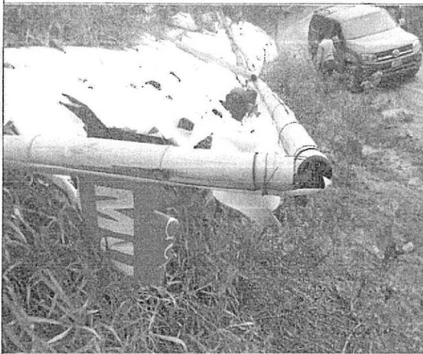
Según el análisis de precios unitarios de la partida 1.01, el soporte del cartel de obra debería ser de Madera Tornillo; sin embargo, tal como se muestra en la fotografía n.º 2, el soporte utilizado no se encuentra acorde a lo establecido en el expediente técnico.
