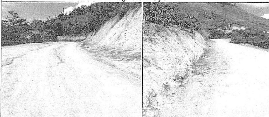
Durante el recorrido del Tramo 1, solo se evidencia trabajos de perfilado con maquinaria, no advirtiéndose las condiciones en el terreno para la ejecución de la partida "Corte Roca Suelta (Perf. y Disp.) con maquinaria.
