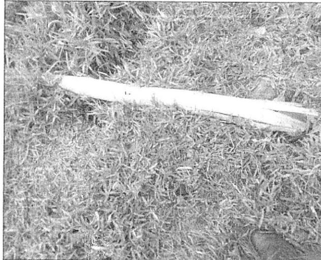
Según el análisis de precios unitarios de la partida 1.01, la base del soporte del cartel de obra debería ser de concreto; sin embargo, tal como se muestra en la fotografía n.º 3, no se encontró la base del soporte, evidenciándose, que este solo fue plantado directamente en el suelo.
