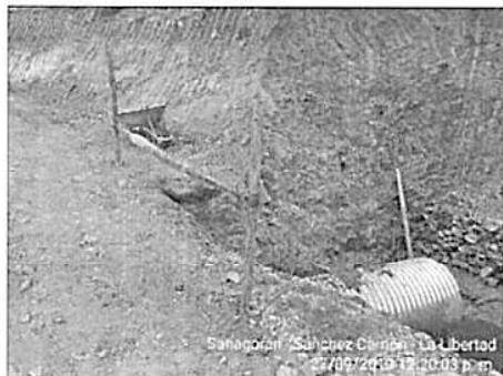
Alcantarilla de la Progresiva 14+101.24, en el que se aprecia la delimitación del área de trabajo de manera deficiente, con parantes no fijos y no estables.
