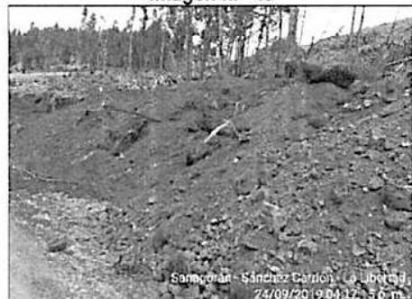
No se aprecia de manera diferenciada el trabajo de desbroce respecto al corte de terreno en diversos tramos de la vía proyectada.
