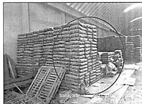
Cemento ubicado en el almacén n.º 1, colocado sobre planchas de madera ( $e=2.5$  cm) y apilados en columnas de hasta 20 bolsas.
