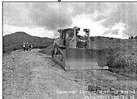
Se aprecia maquinaria realizando el corte de terreno en diversos tramos de la vía proyectada, en los que no se ha ejecutado el desbroce y limpieza de terreno.
