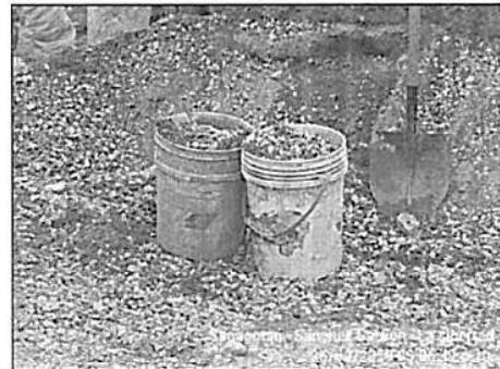
El material utilizado en la mezcla de concreto no cumple con las especificaciones técnicas; no se aprecia la grava y la arena gruesa por separado, que permita verificar su granulometría.
