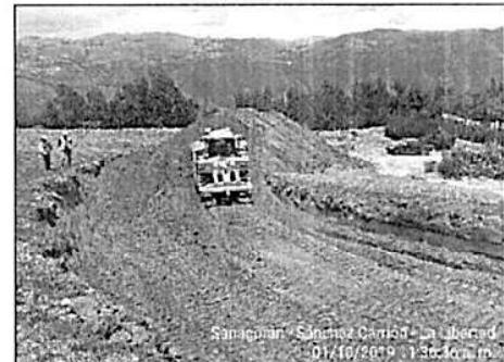
Se advierte que los señaleros no emplean tranqueras, equipos portátiles, señales y dispositivos, en el corte de material suelto realizado por la maquinaria pesada.
