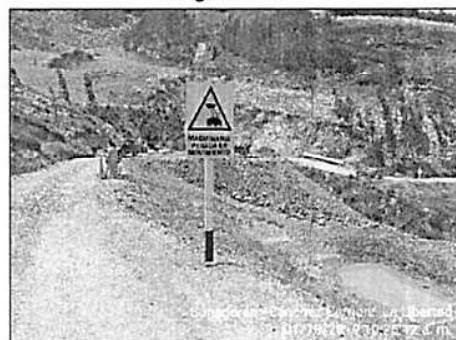
Poca señalización en el puente vehicular de la Progresiva 7+940, apreciándose la no utilización de dispositivos y la cantidad indicada en la partida "01.04 Mantenimiento de tránsito temporal y seguridad vial".
