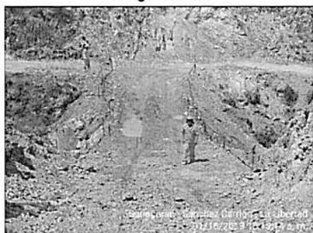
Acceso provisional en el puente vehicular de la Progresiva 7+940, en el que se aprecia la delimitación del área de trabajo de manera deficiente, con parantes no fijos (eucaliptos) y no estables.
