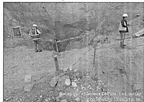
Alcantarilla ubicada en la Progresiva 14+305, en el que se aprecia la delimitación del área de trabajo de manera deficiente, con parantes no fijos y no estables.
