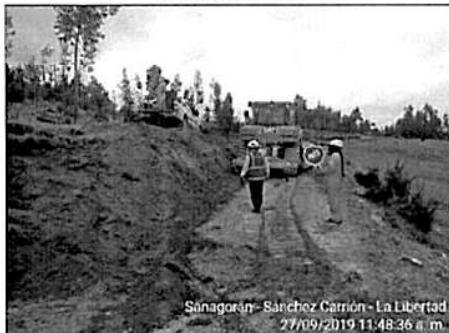
En la actividad de corte en material suelto, se advierte que los señaleros no emplean las tranqueras, equipos portátiles, señales y dispositivos necesarios.
