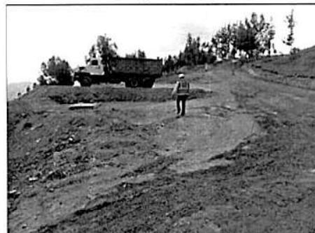
El material producto del corte del terreno es colocado en el lado opuesto de la vía y no en un DME cerca de la progresiva 17+000.
