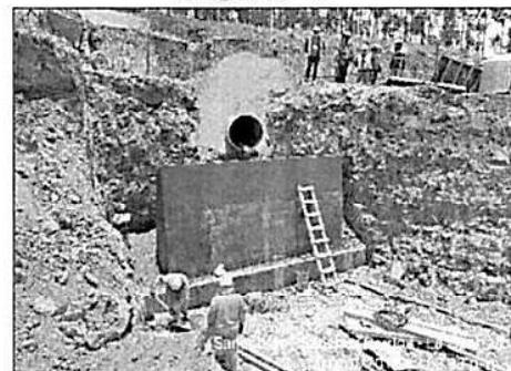
Construcción de alcantarilla progresiva 14+101.24 con cambio de diseño en la salida por las condiciones naturales del terreno
