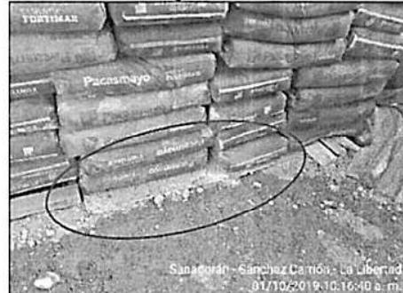
Cemento en almacén, ubicado en la progresiva 7+940, almacenado sobre planchas de madera ( $e=2.5$  cm), apilado en rumas de doce (12) unidades.
