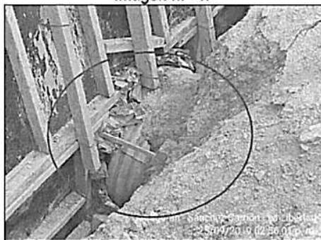
El encofrado no presenta un buen empalme con la alcantarilla TMC Ø36" en la caja receptora (abertura circular), como resultado del mal corte realizado.
