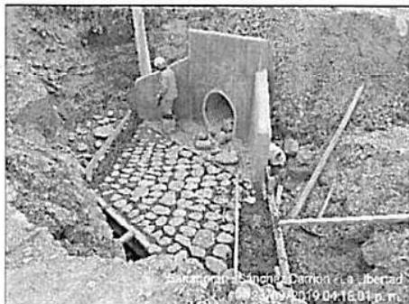
Alcantarilla en la Progresiva 15+020, en el que se aprecia la delimitación del área de trabajo de manera deficiente, con parantes no fijos y no estables.
