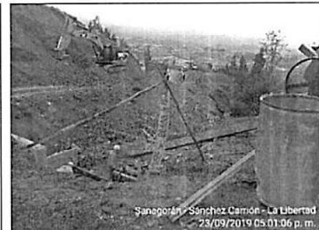
Otra vista del material producto del corte del terreno es colocado en el lado opuesto de la vía y no en un DME cerca de la progresiva 17+000.
