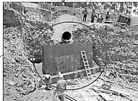
Se aprecia la modificación del diseño (cabezal alero) en la alcantarilla TMC de la progresiva 14+101.24, por las condiciones naturales del terreno.
