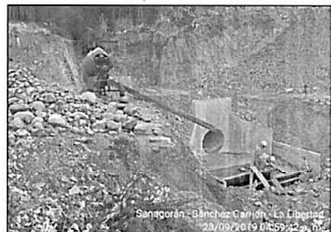
Alcantarilla ubicada en la Progresiva 17+021.63, en el que se aprecia la delimitación del área de trabajo de manera deficiente, con parantes no fijos y no estables.
