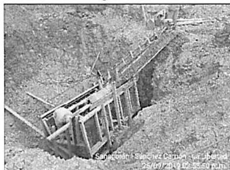
Vaciado de concreto de los muros de la caja receptora correspondiente a la alcantarilla de la progresiva 7+940.
