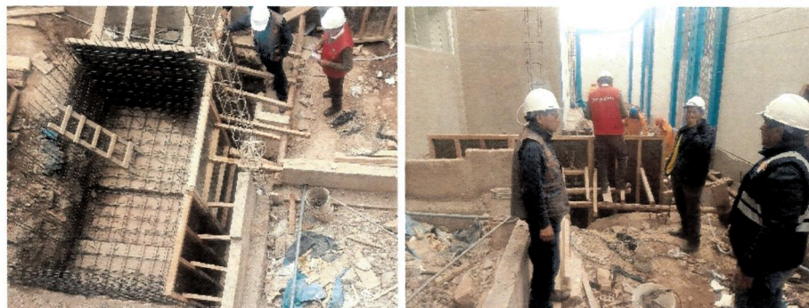
Fotografía N°s 6 y 7: Imagen donde se aprecia la ejecución de trabajos de acero de refuerzo y encofrado para tanque cisterna.
