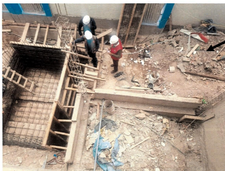
Fotografía N° 12: Material excedente de limpieza acumulado en obra, que debe eliminarse de obra, representa riesgo para el personal de la Obra.
