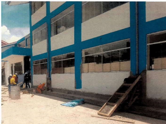
Fotografía N° 2: Exteriores de la Zona del Módulo 2, se aprecia la falta de privacidad para los ambientes de gestión administrativa y pedagógica de la Institución Educativa Fuente: Acta N° 08-2019-CG/GRPU-CS-MPSRJ de 9 de diciembre de 2019.
