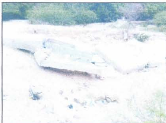
Losa de amortiguamiento totalmente colapsada por el socavamiento del área donde está conformada, no existe ningún tipo de mejoramiento de dicho terreno, son arenas sueltas.
