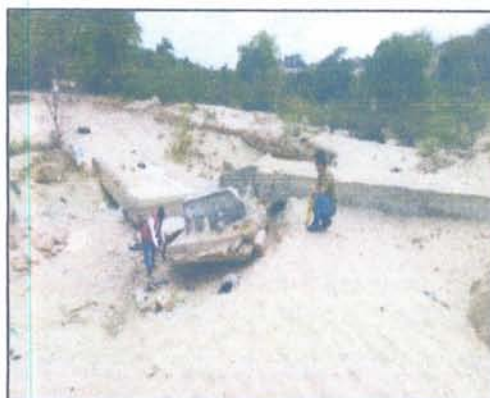
Losa de amortiguamiento totalmente colapsada por el socavamiento del área donde está conformada, no existe ningún tipo de mejoramiento de dicho terreno, son arenas sueltas.
