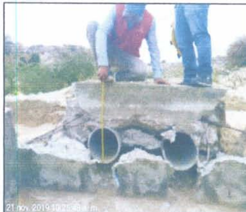
Losa de amortiguamiento totalmente colapsada por el socavamiento del área donde está conformada, no existe ningún tipo de mejoramiento de dicho terreno, son arenas sueltas.
