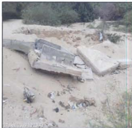
Losa de amortiguamiento totalmente colapsada por el socavamiento del área donde está conformada, no existe ningún tipo de mejoramiento de dicho terreno, son arenas sueltas.
