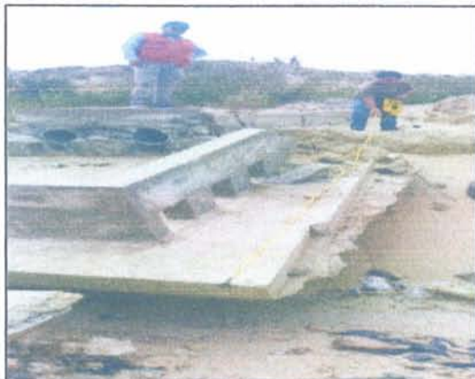
Losa de amortiguamiento totalmente colapsada por el socavamiento del área donde está conformada, no existe ningún tipo de mejoramiento de dicho terreno, son arenas sueltas.
