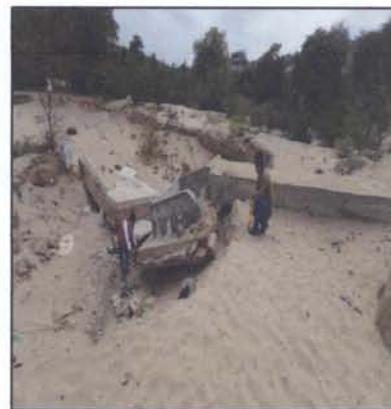
Losa de amortiguamiento totalmente colapsada por el socavamiento del área donde está conformada, no existe ningún tipo de mejoramiento de dicho terreno, son arenas sueltas.
