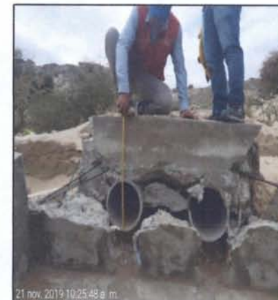
Losa de amortiguamiento totalmente colapsada por el socavamiento del área donde está conformada, no existe ningún tipo de mejoramiento de dicho terreno, son arenas sueltas.
