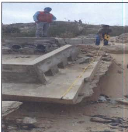
Losa de amortiguamiento totalmente colapsada por el socavamiento del área donde está conformada, no existe ningún tipo de mejoramiento de dicho terreno, son arenas sueltas.
