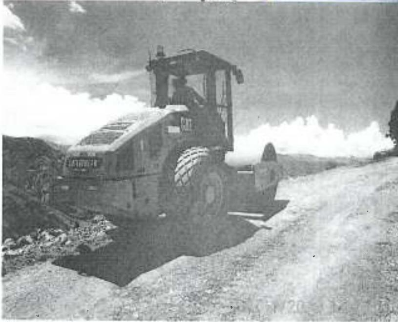
Se observo trabajos de compactación de material granular a nivel de base con un rodillo compactador vibratorio liso, entre las progresivas km. 7+500 al km. 7+850.
