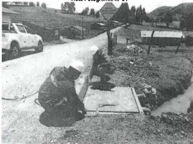
Se evidenció la caja de inspección ubicada en el margen izquierdo de la plataforma a la altura de la progresiva km. 5+540 aprox., de sección cuadrada y dimensiones de 1.30 m. x 1.30 m. con tapa de concreto.
