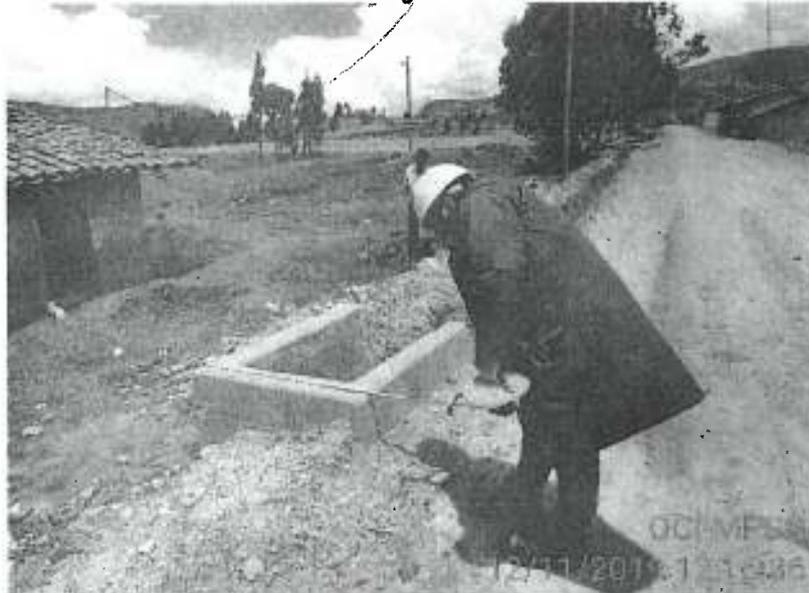
Se evidenció la caja de inspección ubicada en el margen izquierdo de la plataforma a la altura de la progresiva km. 4+500 aprox., de sección en "u" y de dimensiones de 0.90 m. x 1.30 m. sin tapa de concreto.
