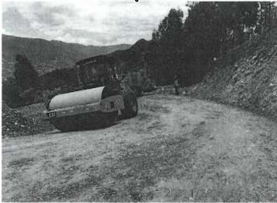
Se evidenció la compactación de la base granular desde la progresiva 8+910 en adelante, utilizando un rodillo liso vibratorio.
