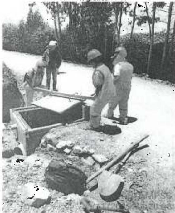
Se evidenció la caja de inspección ubicada en el margen derecho de la plataforma a la altura de la progresiva km. 5+450 aprox., de dimensiones de 1.30 m. x 1.30 m. con tapa de concreto.
