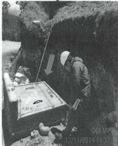
Se evidenció la caja de inspección ubicada en el margen derecho de la plataforma a la altura de la progresiva km. 6+140 aprox., de sección cuadrada y dimensiones de 1.30 m. x 1.30 m. con tapa de concreto.
