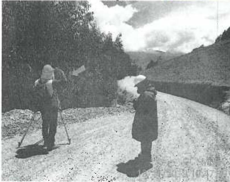
Se efectuaba nivelación topográfica y trazo de los ejes de la carretera entre las progresivas km. 3+000 al km. 4+000.
