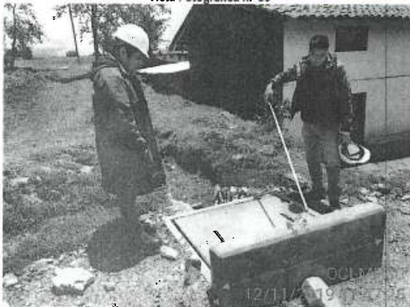
Se evidenció la caja de inspección ubicada en el margen derecho de la plataforma a la altura de la progresiva km. 5+540 aprox., de sección cuadrada y dimensiones de 1.30 m. x 1.30 m. con tapa de concreto.
