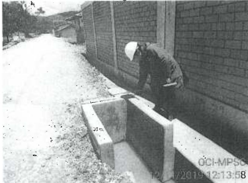
Se evidenció la caja de inspección ubicada en el margen derecho de la plataforma a la altura de la progresiva km. 4+500 aprox., de sección en "u" y de dimensiones de 0.90 m. x 1.30 m. sin tapa de concreto.
