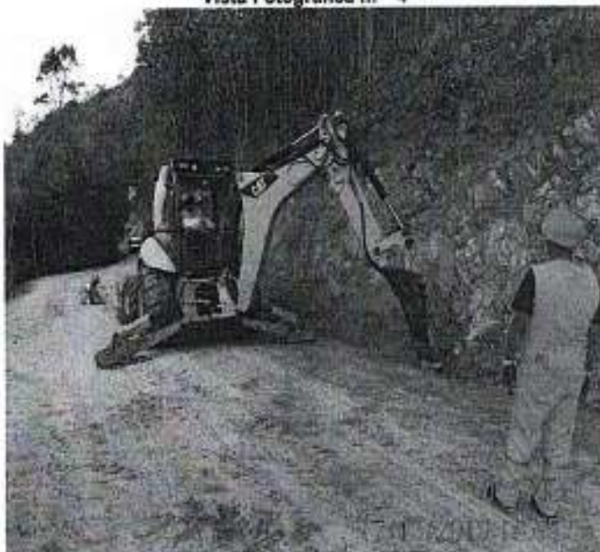
Conformación de cuneta, con maquinaria de línea amarilla
