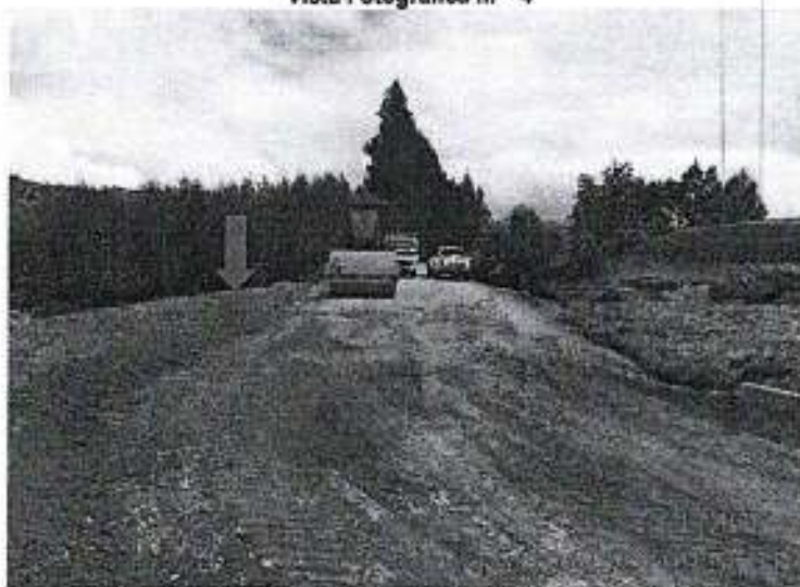
Trabajos de mejoramiento de base en la progresiva km. 5+050 aproximadamente
