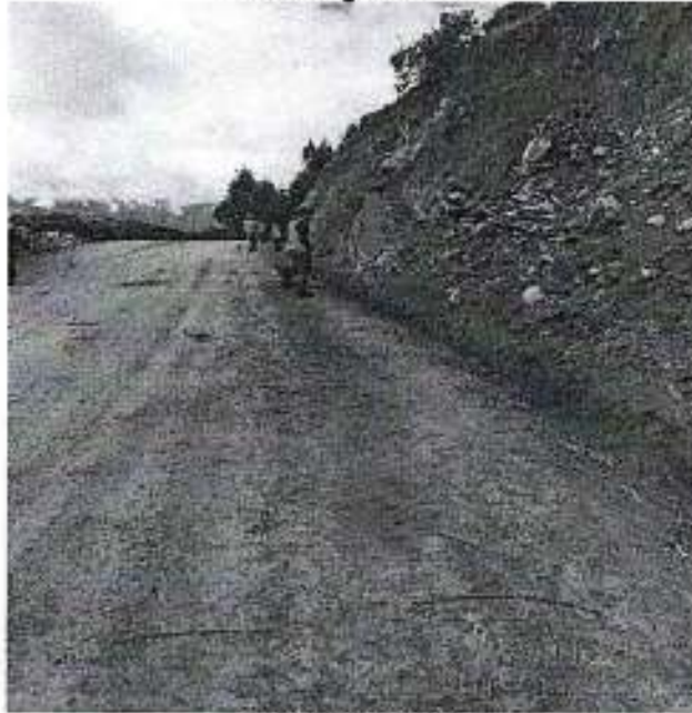
Conformación de cuneta
