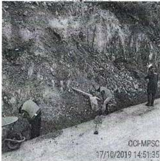
Perfilado y conformación de cuneta
