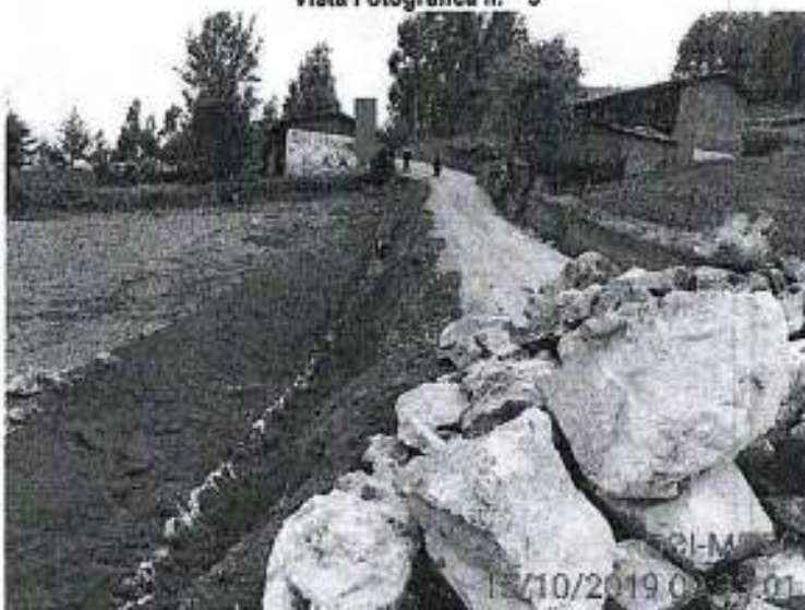
Corte de terreno para estabilización de terreno con mampostería (muro seco) en la progresiva km. 0+100 a 0+200
