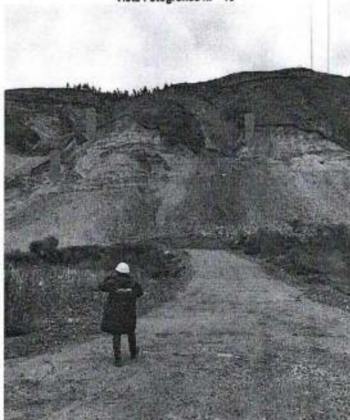
Trabajos de corte de terreno para conformación de la carretera, que viene ejecutándose por el trazo contractual que fue eliminado por el adicional deductivo vinculante n.º 1.
