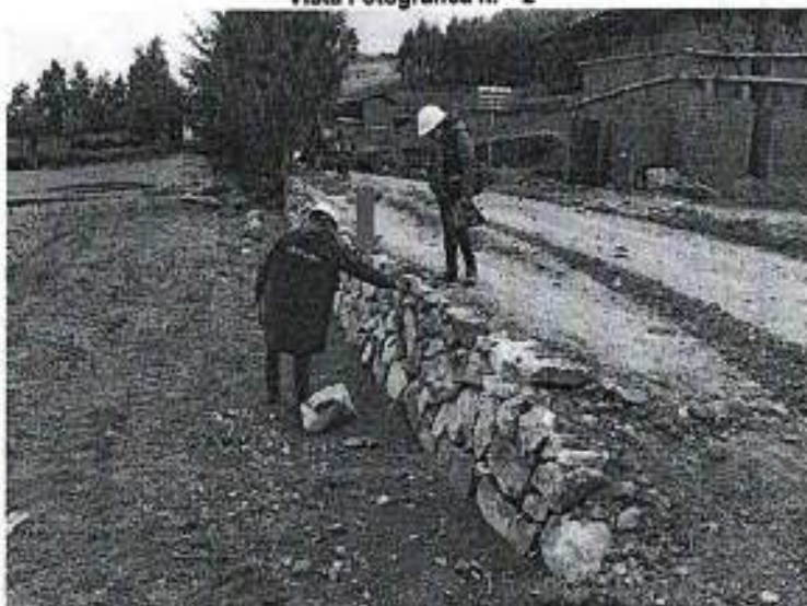
Estabilización de terreno con mampostería (muro seco) en la progresiva km. 0+100
