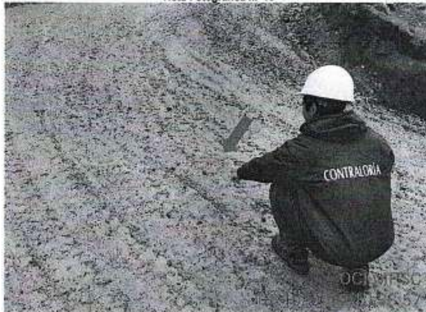
Se observó el lavado y la desintegración del material granular de la base, por efectos de la lluvia.
