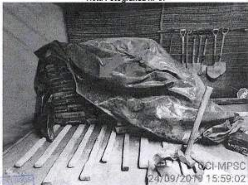
Se observó el almacenaje del cemento portland tipo I.
