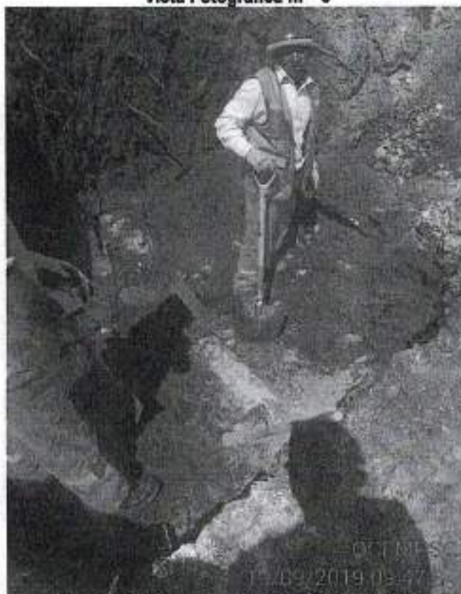
Personal obrero realizando trabajos de excavación de zanjas para caja de inspección para regadío de agua progresiva km 4+100 aproximadamente.
