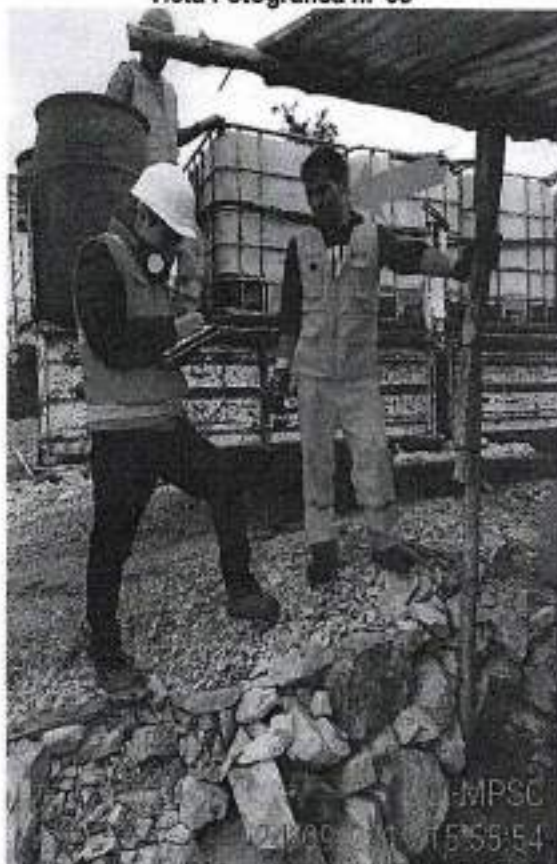
Obrero: Javier Contreras Ruiz (no cuenta con casco, respirador contra gases tóxicos y lentes).
