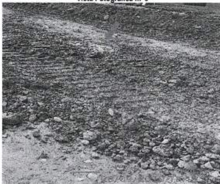
Se observó la saturación del material granular que será utilizado para la conformación de la base
