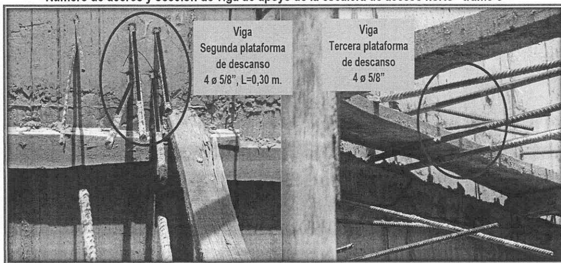
Fotografía n.º 3 Numero de aceros y sección de viga de apoyo de la escalera de acceso norte - tramo 3
