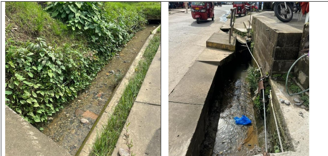
Panel Fotográfico n.º 1 Colmatación de canales abiertos en la zona alta del Pueblo Joven 9 de Octubre
