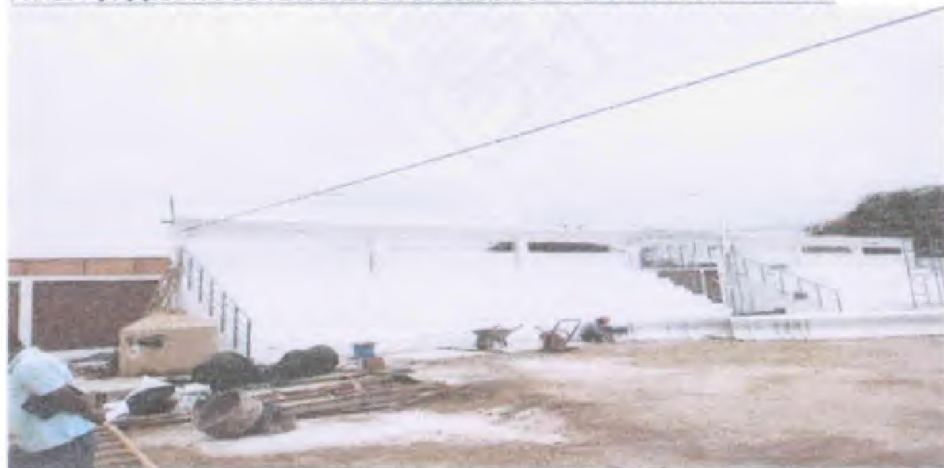
FOTO N° 01: COLOCACION DE TENSORES EN COLUMNAS DE TRIBUNAS
