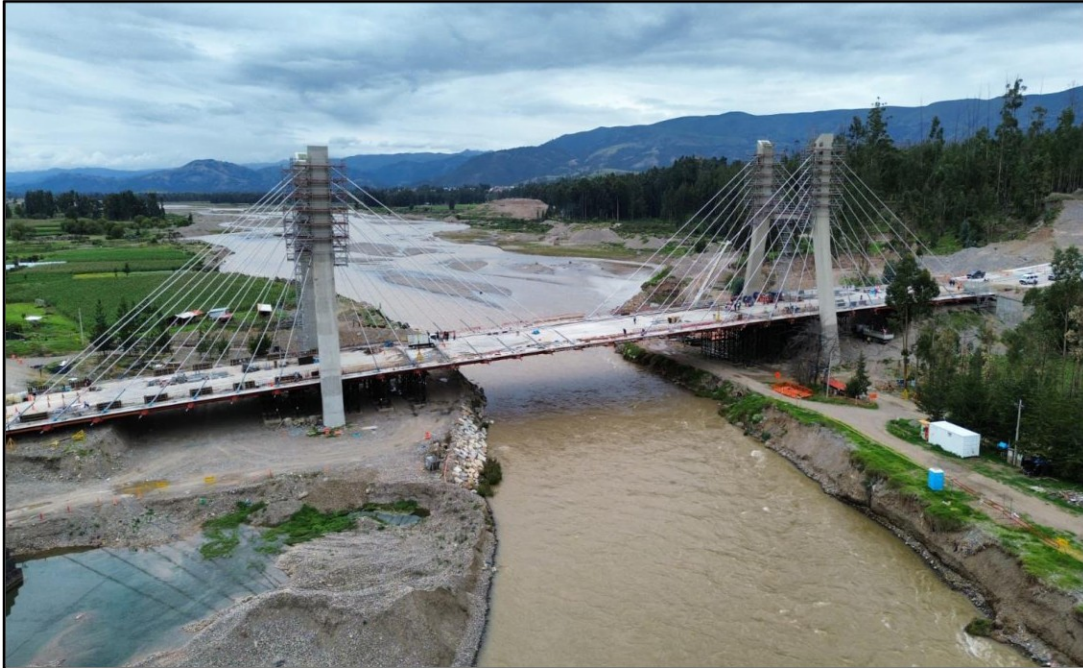
Fotografía n.º 1 Vista panorámica del avance de la ejecución de la Obra
