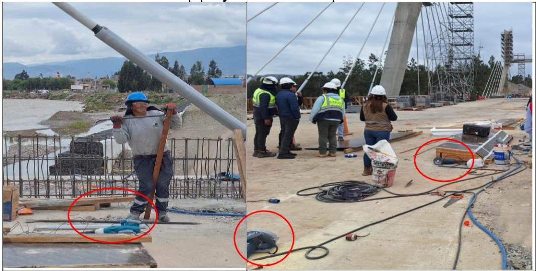
Panel fotográfico n.º 4 Equipos y herramientas en el piso
