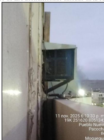
Imagen n.º 15 Soporte del equipo de aire acondicionado ubicado en la estación de Pacocha
