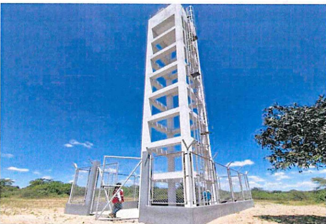
Fotografía n.º11.- Vista de frontis del reservorio de tanque elevado
