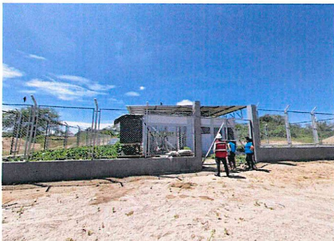
Fotografía n.º1.- Visita de inspección a la caseta de pozo tubular.
