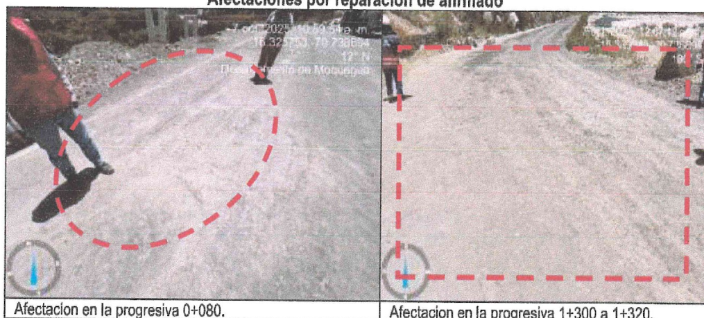
Imagen n.º 7 Afectaciones por reparación de afirmado
