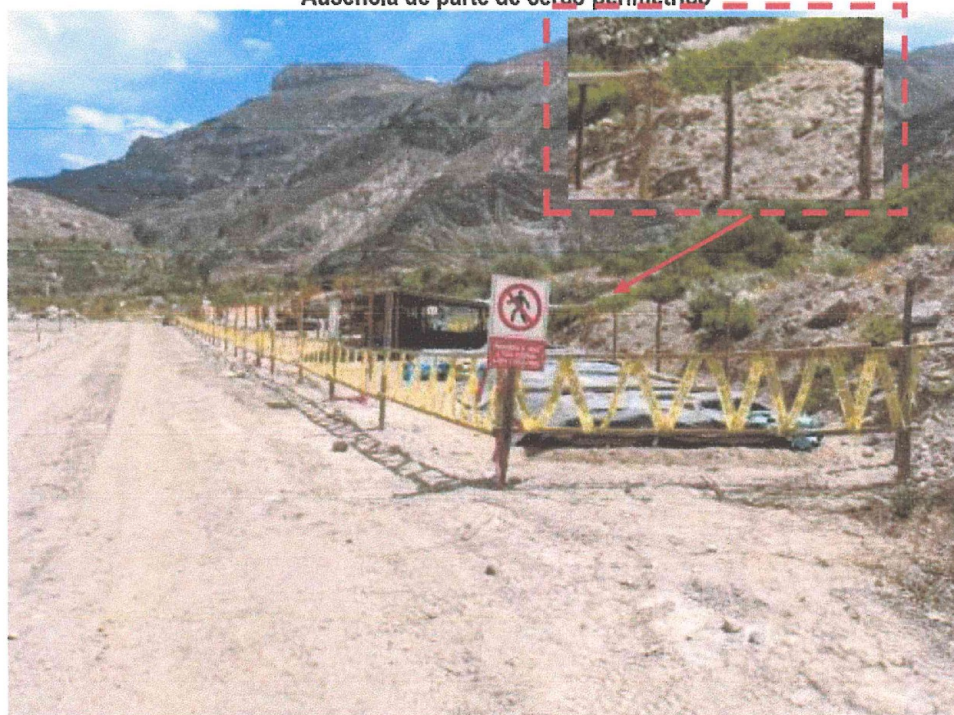
Imagen n.º 21 Ausencia de parte de cerco perimétrico
