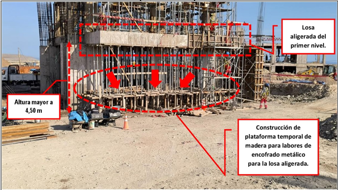
Imagen n.º 86 Construcción de plataforma temporal de madera
