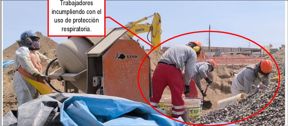
Imagen n.º 52 Personal obrero incumpliendo el uso de mascarillas antipolvo con dispositivo filtrante
