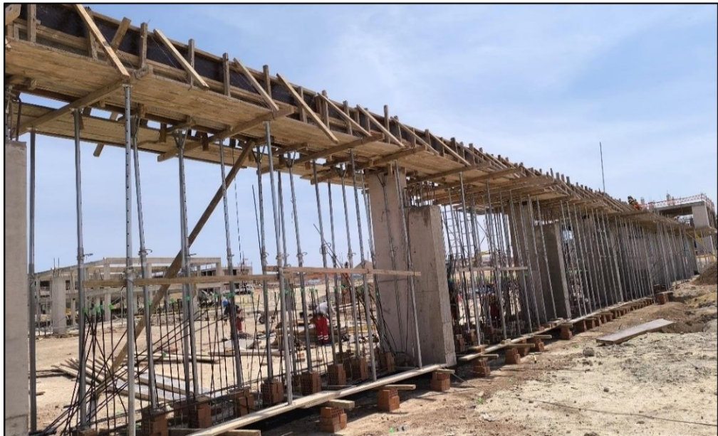
Imagen n.º 68 Puntales metálicos para el encofrado del fondo de viga y plataforma para circulación del personal técnico y obrero se encuentran apoyados sobre 3 filas de ladrillo.
