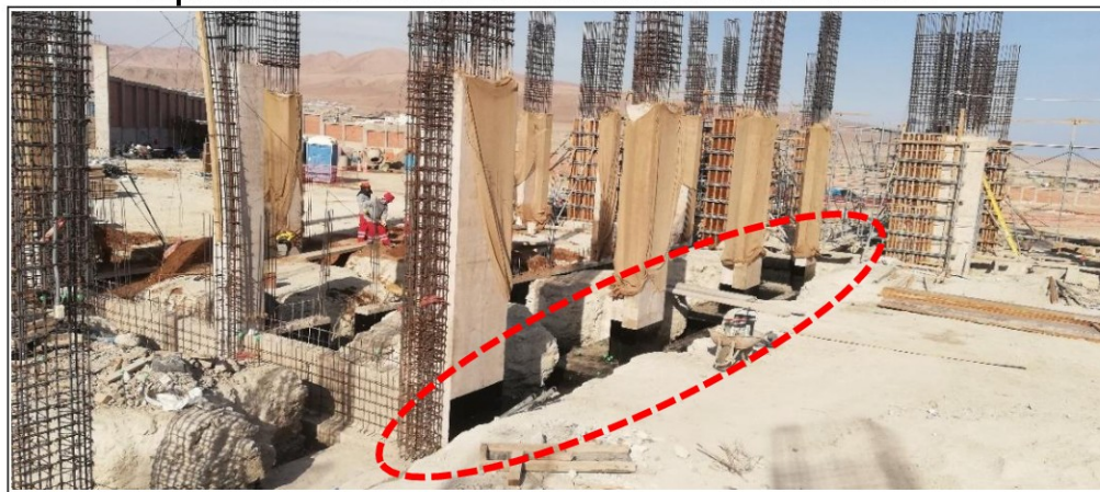
Impermeabilización de elementos estructurales de cimentación
