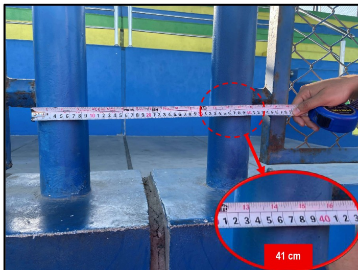
FOTOGRAFÍA N° 14 ESPACIAMIENTO ENTRE TUBOS VERTICALES DE LAS GRADERÍAS (PARTE INFERIOR)
