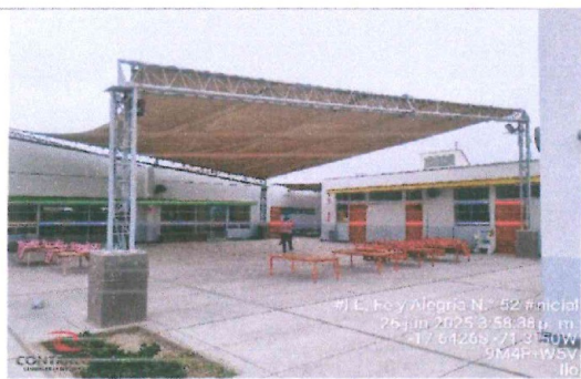
Imagen n.° 36: Cobertura liviana en patio de inicial.
