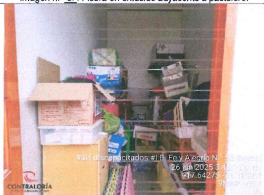
Imagen n.° 39: Servicios higiénicos de discapacitados utilizado como almacén.
