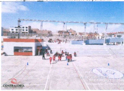
Imagen n.° 33: Losas deportivas descubiertas exponiendo a sus usuarios a los rayos solares nocivos para la salud.
