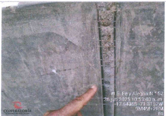
Imagen n.° 34: Relleno de junta en sobrecimiento de cerco perimétrico.
