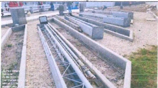
Imagen n.° 19: Estructura metálica de la cobertura de lona retirada
